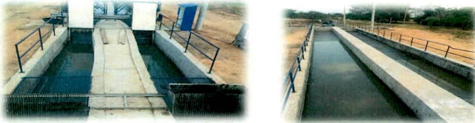
Se realiza periódicamente el retiro de arenas y lodo del tren 1 y 2 del desarenador, de igual forma el sistema de rejillas automáticas, ha tenido una operación discontinua pues se han presentado problemas de mantenimiento en las cadenas.
