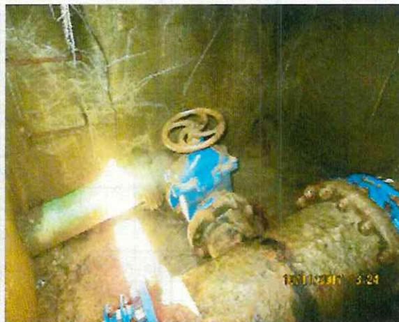
**Imagen 3.** Purgas para la Extracción de sedimentos.
