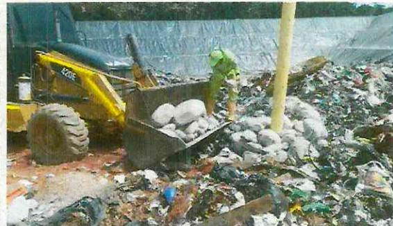
Imagen 12. Estado actual Adecuación y conformación de chimeneas.
