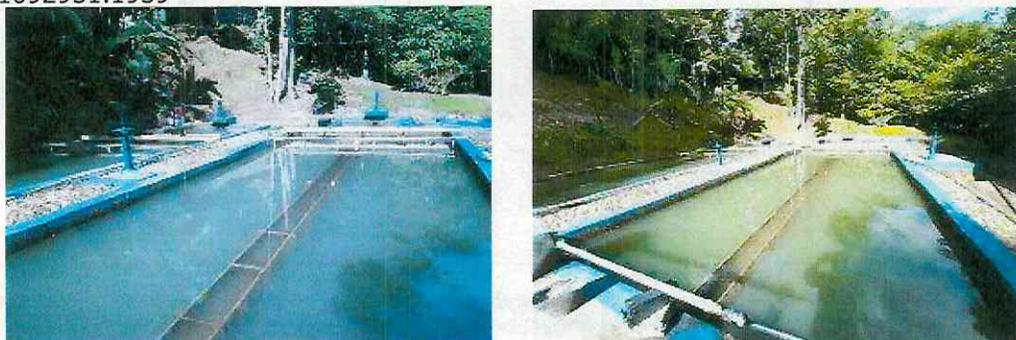
Imagen 2. Desarenador línea de 18" y línea de 16".
