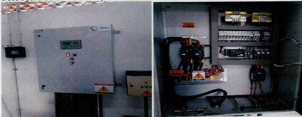
Terminación de la instalación del tablero de control para dos electrobombas de 15 hp autocebantes alternadas.
