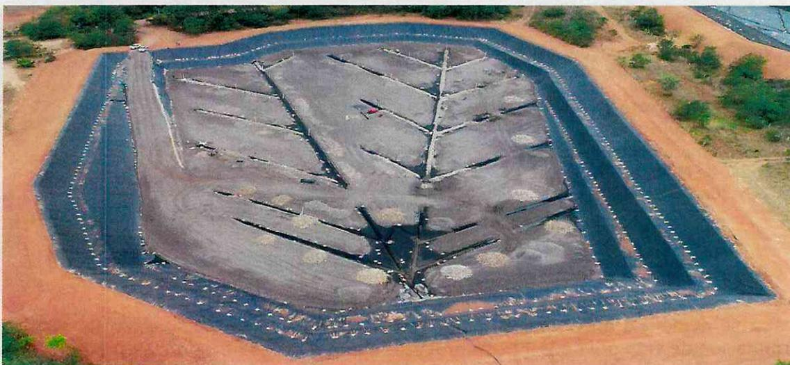
Imagen 1 y 2. Construcción trinchera 10 y 11 Relleno sanitario el Cascajar
