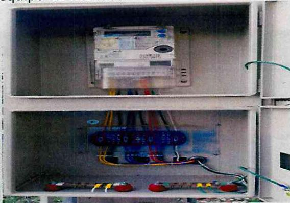
Terminación de optimización de tablero de banco de condensadores para dos electrobombas de 35 Y 35 HP.
