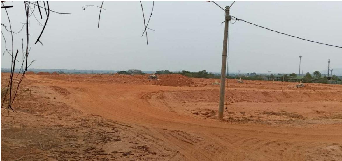
*Trinchera No T13 cerrada con material granular y en proceso de asentamiento- registro Marzo de 2020*
