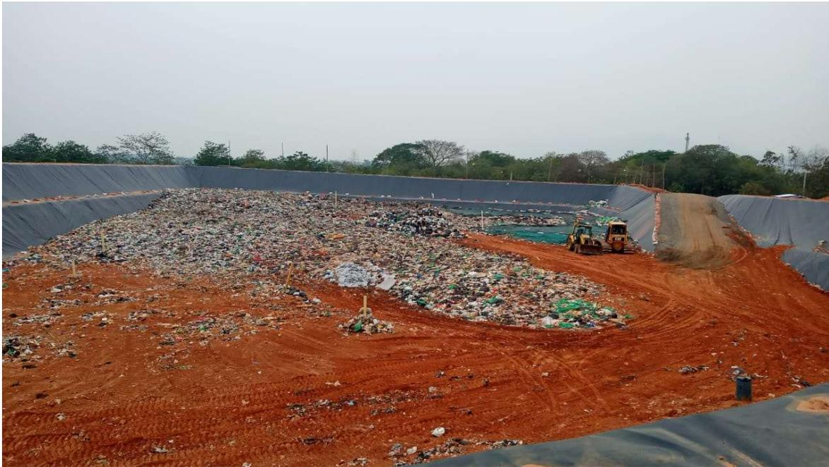
De acuerdo con lo establecido en el frente de trabajo en la celda de operación y como se observa en la fotografía anterior tomada el pasado mes de Marzo de 2020, en la cual se observan las coberturas intermedias utilizando material granular y material plástico tipo lona, lo que permite minimizar los olores en la celda de operación.
