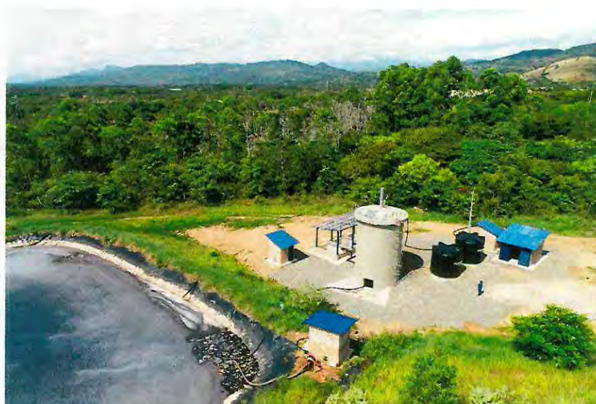
Planta de tratamiento de Lixiviados
