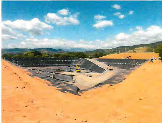
Avance construcción trinchera No. 12
