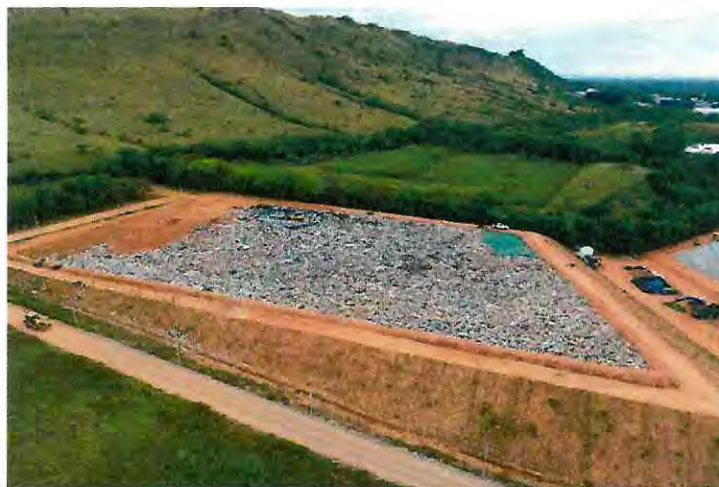
Trinchera No. 13 actualmente
