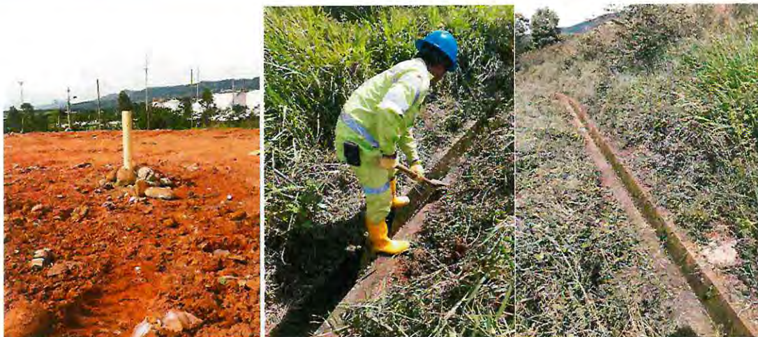
Chimenea ubicada en la Trinchera N° 13 y Mantenimiento de canal perimetral para aguas lluvias.
