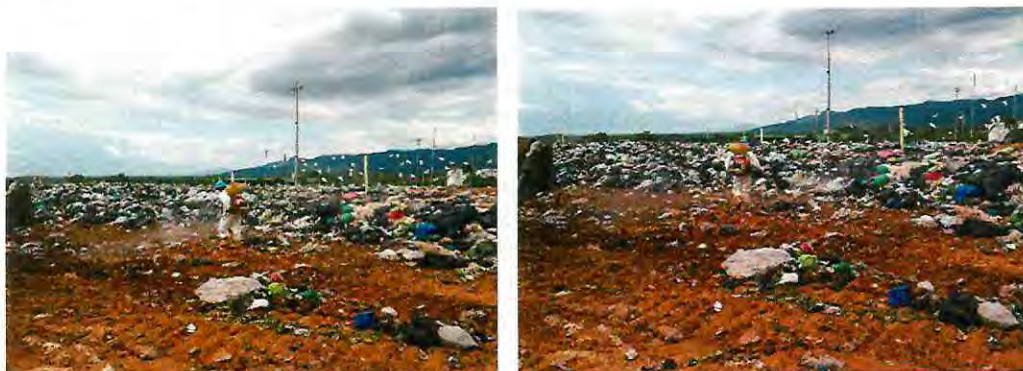
Aspersión de biológico en la celda de operación
