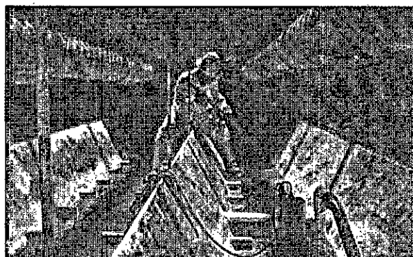
Foto Lavado Sedimentadores
