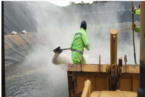
Aplicación de cal
