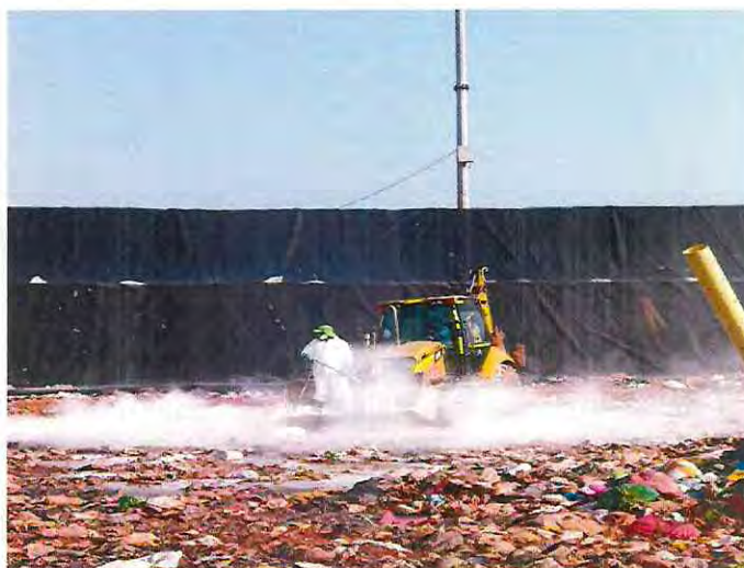
Aplicación de cal sobre los residuos en celda
