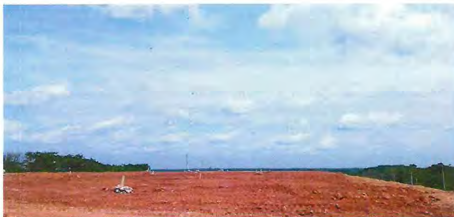
Manejo de Aguas de escorrentía
