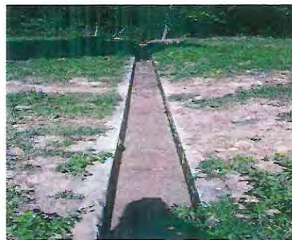
Canales perimetrales Manejo de Aguas Lluvia
