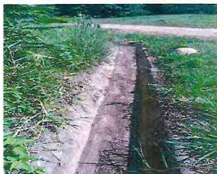
Canales perimetrales Manejo de Aguas Lluvia
