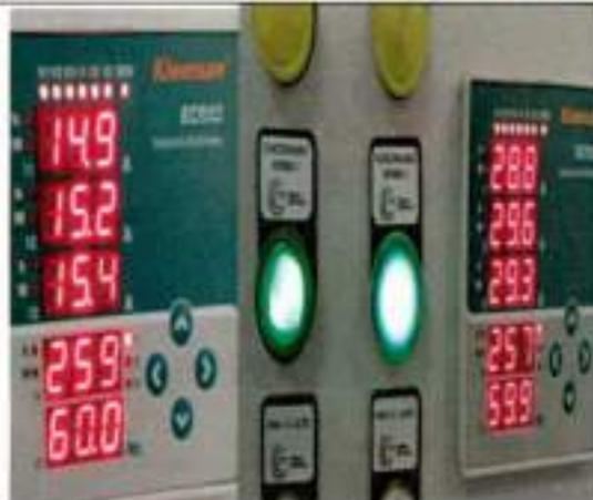
Se realiza monitoreo de voltaje, amperaje, frecuencia y temperatura de electrobombas autocebantes de 15hp, 11.3hp. Operación normal
