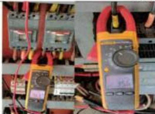
Se realiza monitoreo de voltaje, amperaje, frecuencia y temperatura de gabinete de 6 electrobomba sumergible de 36hp No. 2 y 5 área de filtros percoladores.
