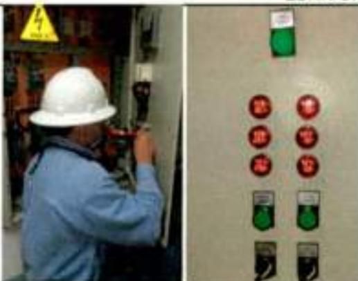
SE REALIZA CAMBIÓ DE VISORES DE VOLTAJE Y AMPERAJE DE LAS ELECTROBOMBAS DE EBAR CIUDAD BERLÍN
