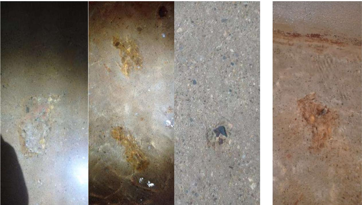
Perdida matriz del concreto, aparición de huecos y posible oxidación acero en placa inferior
