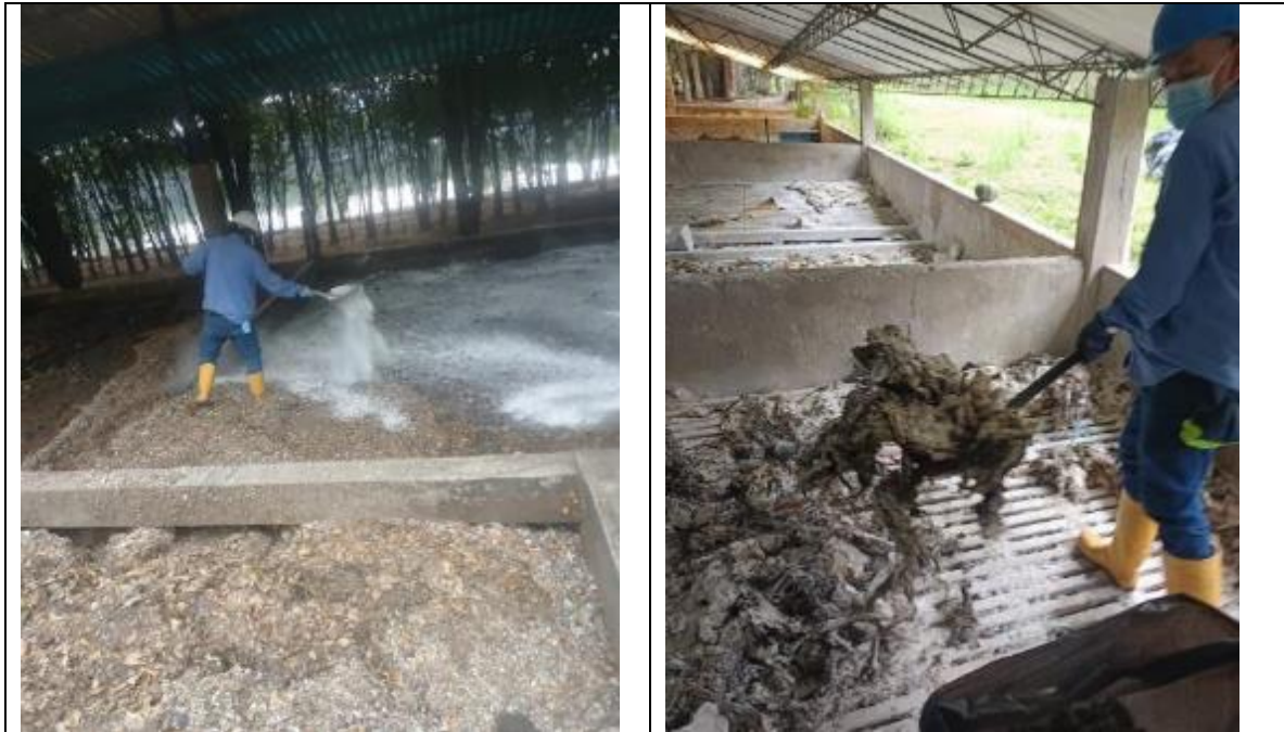
Ilustración 47 deshidratación, volteo y retiro de lodos secos
