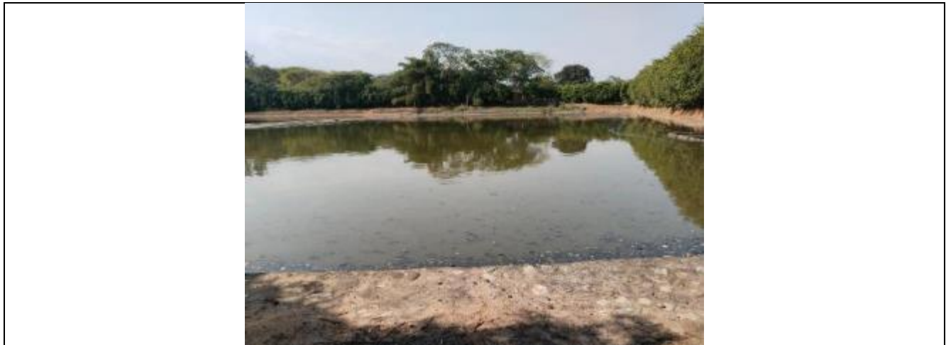
Ilustración 32 limpieza manual y con apoyo de equipo succión de sobrenadantes laguna anaerobia 1.
