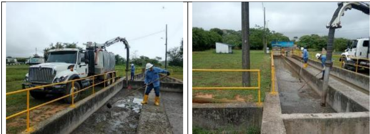
Ilustración 34 Extracción sobrenadantes en desarenadores con apoyo equipo succión
