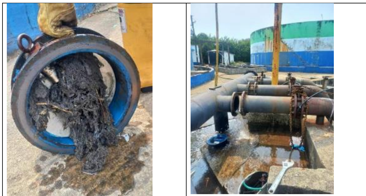
Ilustración 40 limpieza y prueba de bombeo Válvulas
