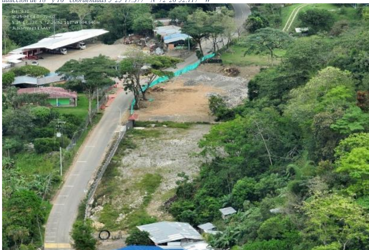
Ilustración 60 Fajas afectadas. Comunidad manifiesta que pretenden construir edificaciones de dos pisos.
