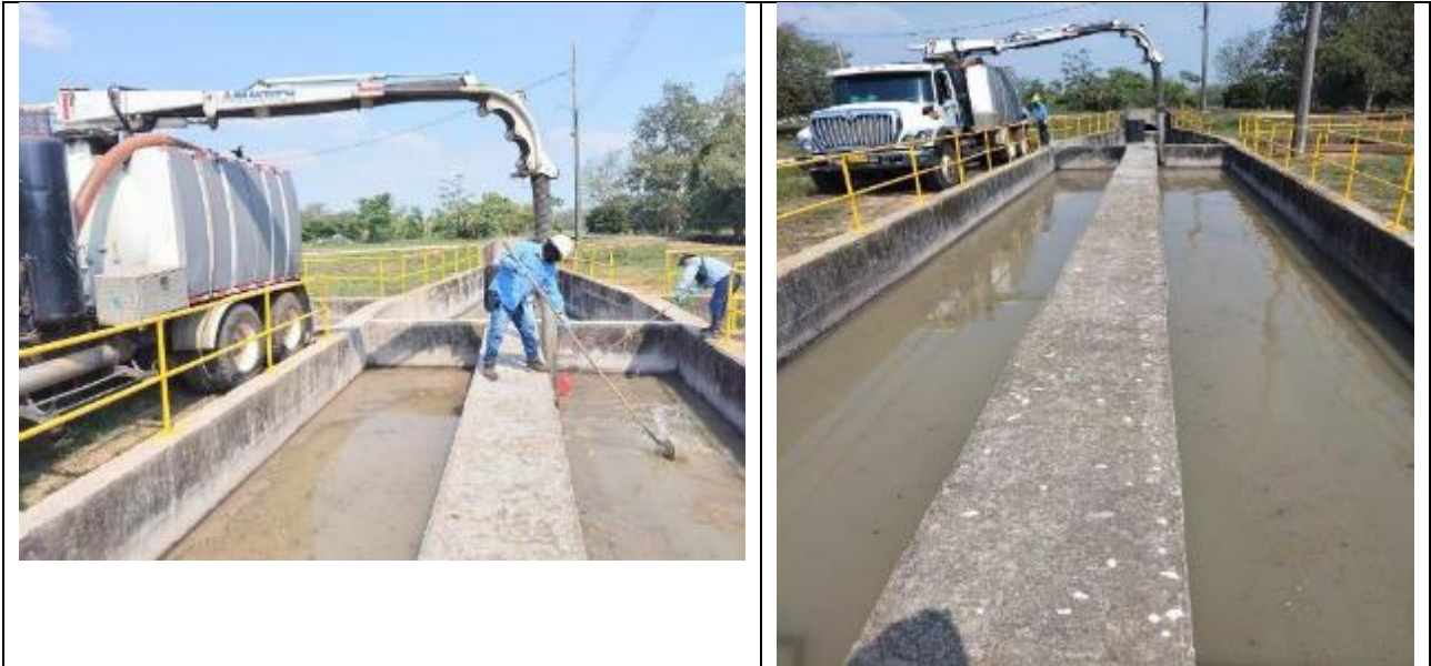
Ilustración 30 Actividad de extracción sobrenadantes en desarenadores con equipo succión
