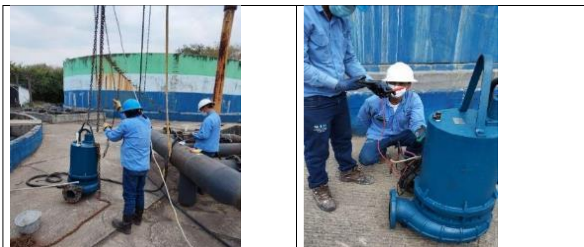
Ilustración 38 Reubicación de bombas sumergibles
