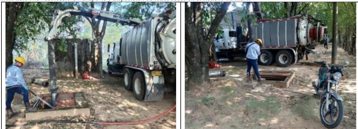
Ilustración 46 Mantenimiento preventivo del tanque asociado y del sistema de drenaje
