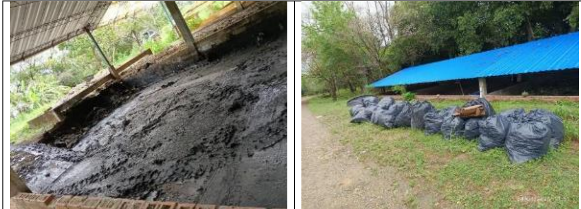
Ilustración 48 Retiro de lodos secos, con apoyo de un minicargador.
