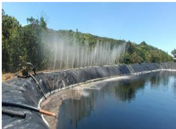
Sistema de aspersión de lixiviados
