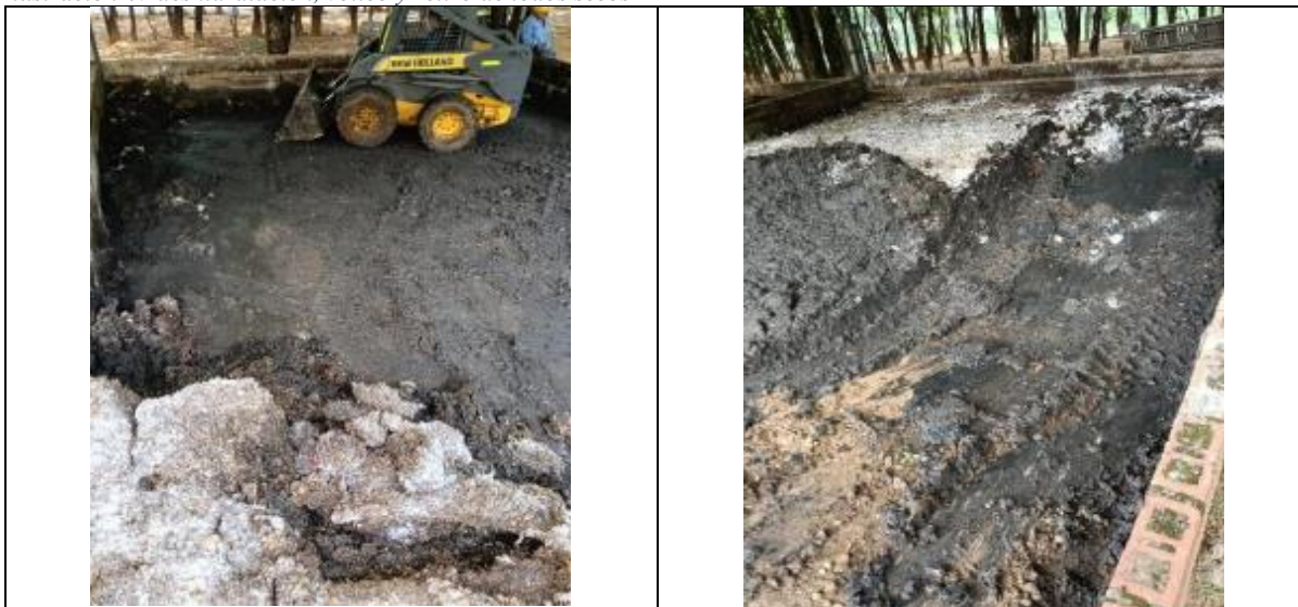
Ilustración 47 deshidratación, volteo y retiro de lodos secos
