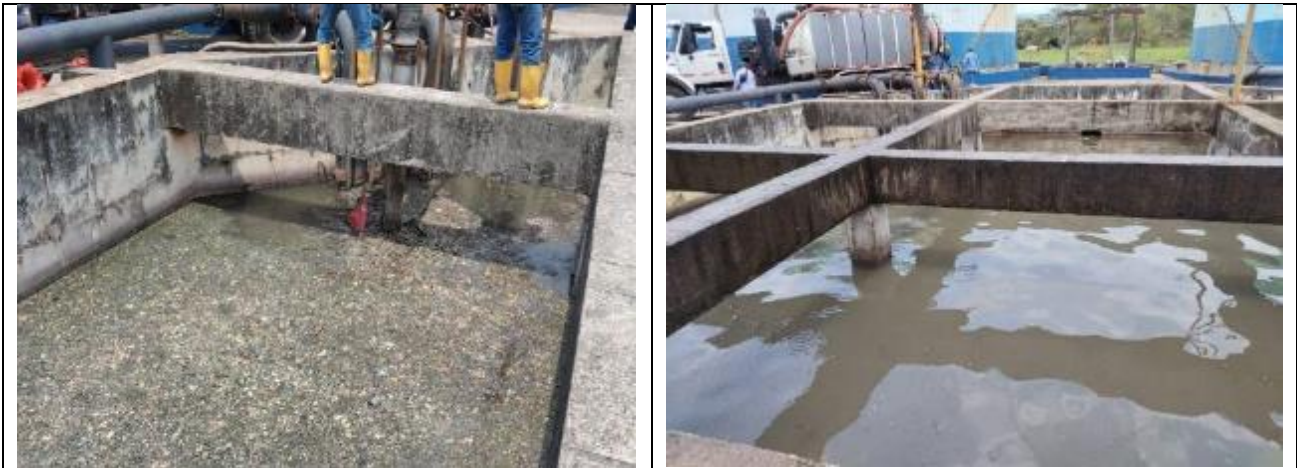
Ilustración 31 Extracción con apoyo de equipo de succión y limpieza tanque de Bombeo
