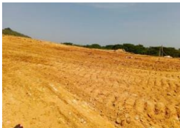
Cobertura con material en la trinchera 10
