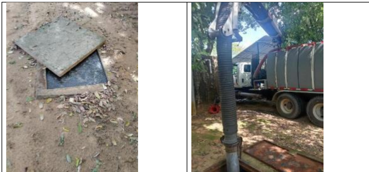
Ilustración 49 Mantenimiento tanque lechos de secado
