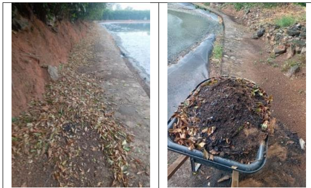
Ilustración 26 Despeje de maleza con apoyo de maquinaria, limpieza y recolección alrededor de las lagunas de oxidación
