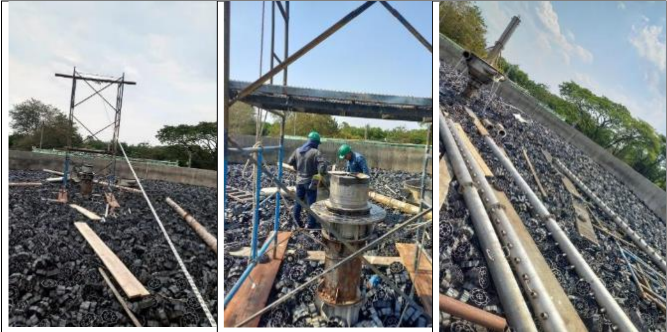
Ilustración 41 optimización de los filtros percoladores No. 1, 2 y 3, mediante el cambio de componentes, mantenimiento integral y su respectiva puesta en marcha
