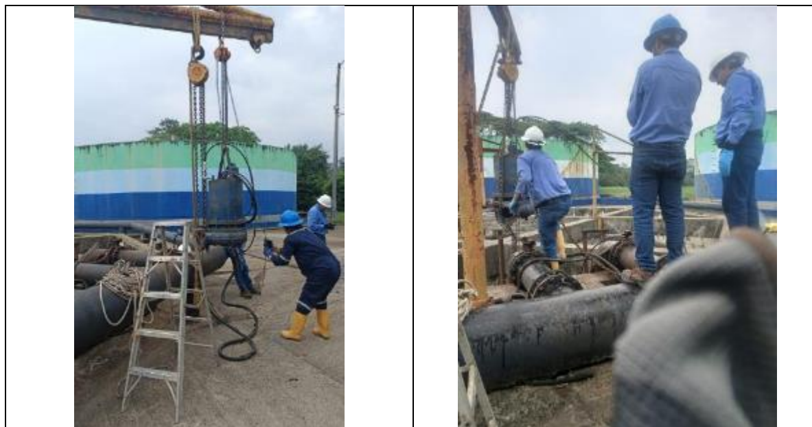
Ilustración 39 Izaje de bombas sumergibles del sector B e instalación manguera de desfogue con apoyo de la unidad electromecánica.
