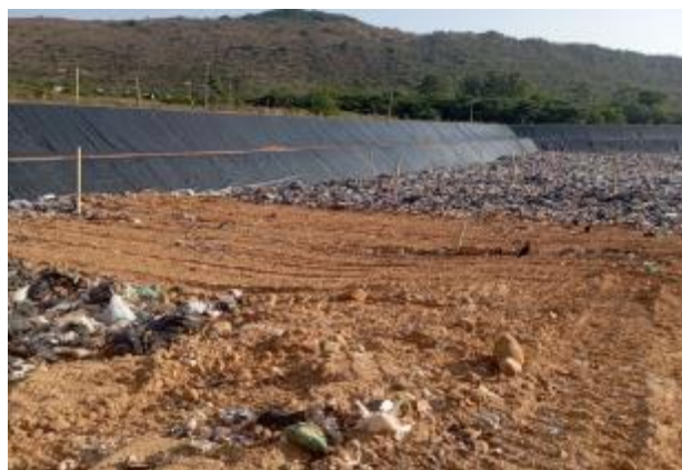
Cobertura con material trinchera en operación 11
