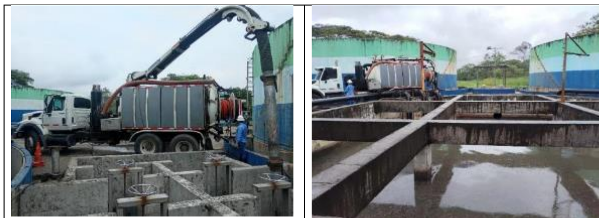
Ilustración 35 En abril se realizó mantenimiento de la cámara de bombeo mediante la extracción con apoyo de equipo de succión.
