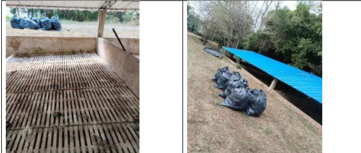
Ilustración 44 deshidratación, volteo y retiro de lodos secos
