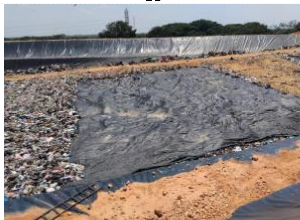
Cobertura con Lona negro verde Trinchera 11
