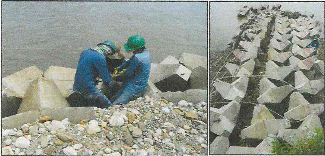
Imagen 7 Proteger el emisario final.Obras de protección márgenes del rio
