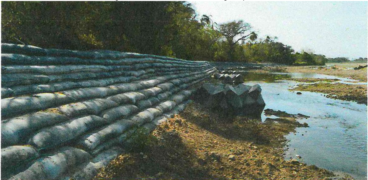
Imagen 8 Instalación de bolsacretos margen izquierda
