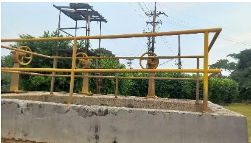
Foto 1 Estructura de Entrada
