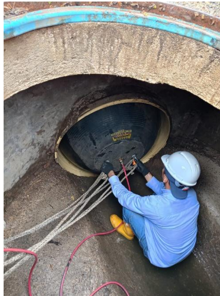
Foto 23 Obturador para tuberías de 20" a 40"
