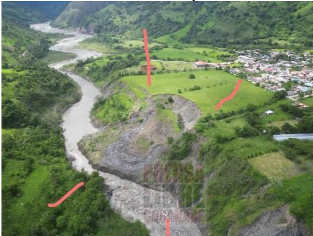
Foto 8 Deslizamiento en Labranzagrande
