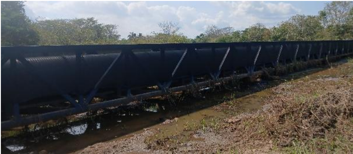
Foto 5 Paso elevado en cercha metálica
