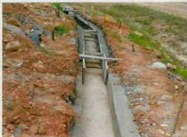
Canales perimetrales Manejo de Aguas lluvia
