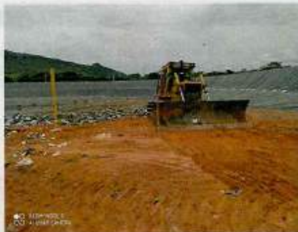
Cobertura material granular
