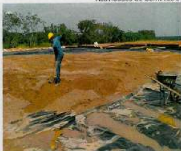
Actividades de Instalación de Capa de Drenaje
