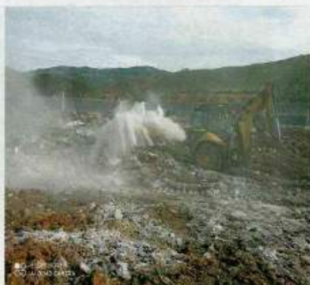
Aplicación de cal
