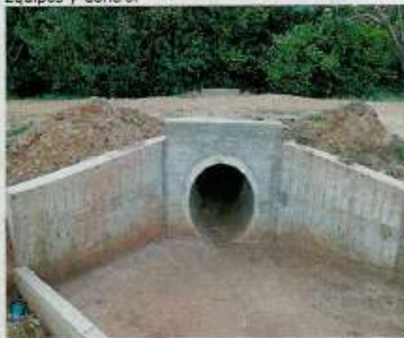
Alcantarilla; para Recoger las Aguas de Escorrentía de los Canales Rectangulares
