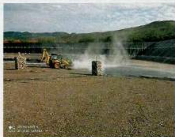
Aplicación de cal
