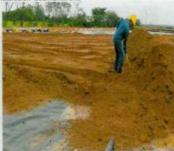
Actividades de Instalación de Capa de Drenaje
