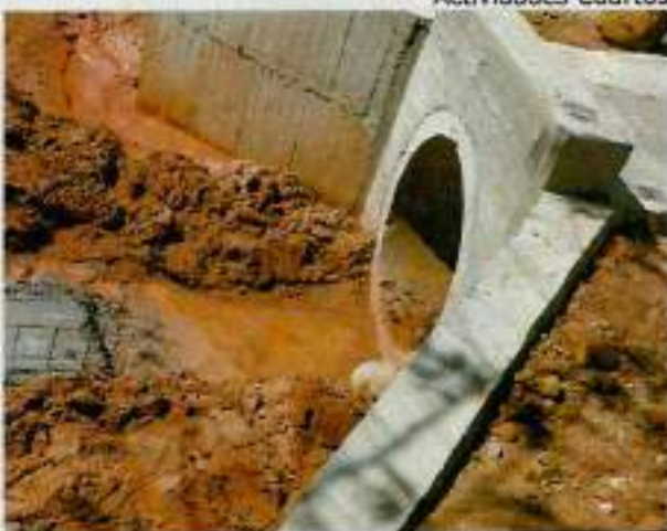
Alcantarilla; para Recoger las Aguas de Escorrentía de los Canales Rectangulares
