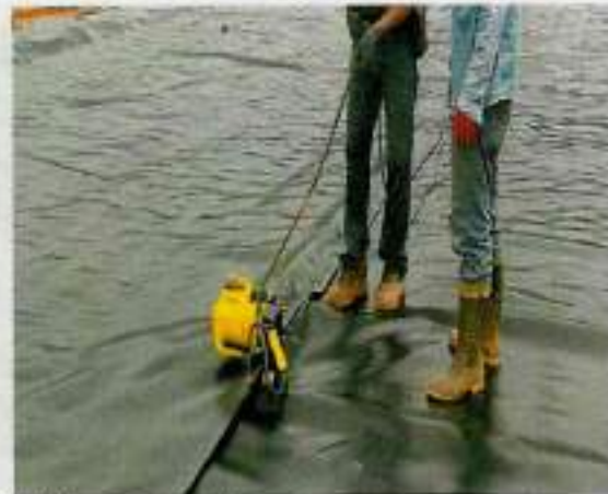
Actividades de Suministro e Instalación Geomembrana
