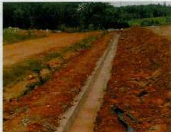
Canales perimetrales Manejo de Aguas lluvia
