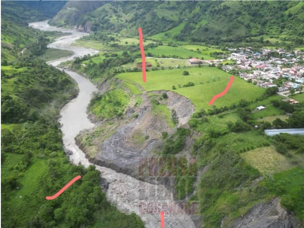
Imagen 12 Deslizamiento en Labranzagrande Tapona Parte del Río Cravo Sur
