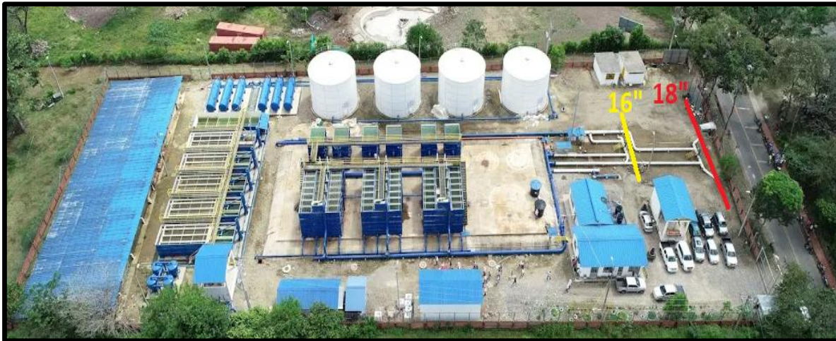
Foto 30 Toma aérea sistema de tratamiento alterno
