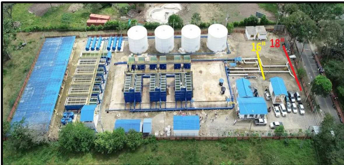
Foto 14 Toma aérea sistema de tratamiento alterno
