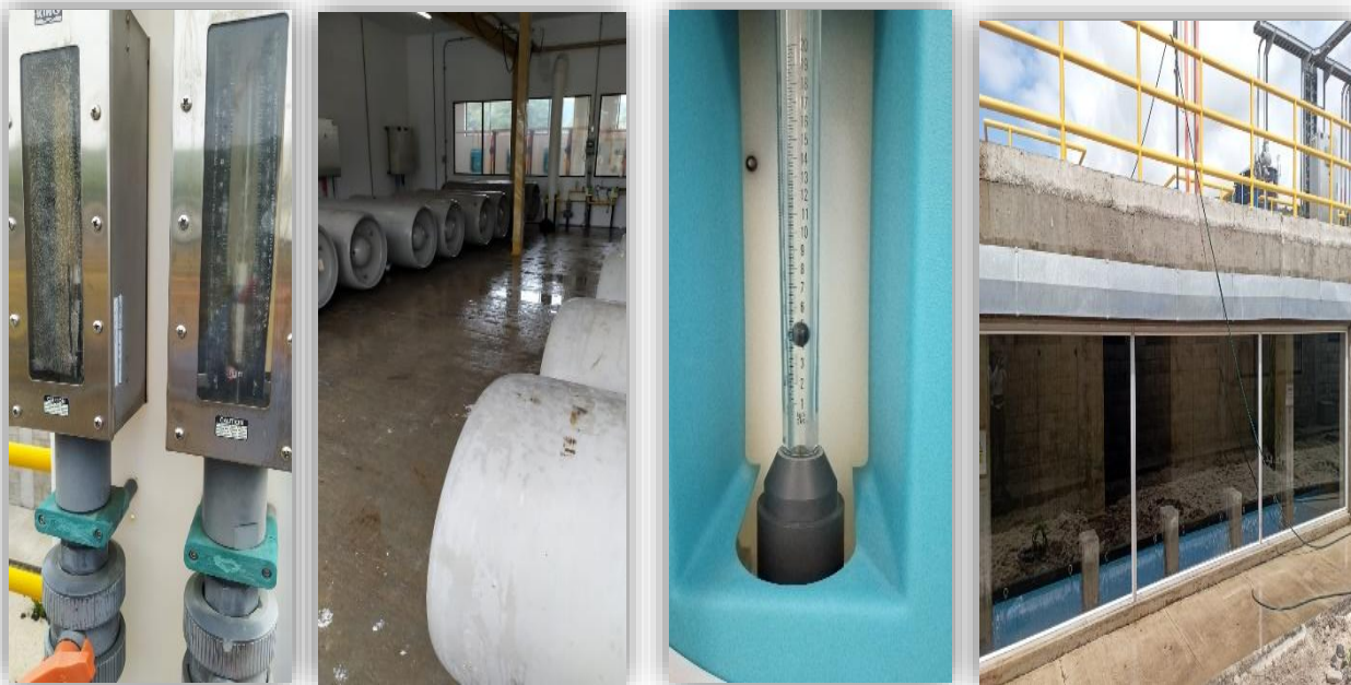
Foto 6 Sistema de cloración
