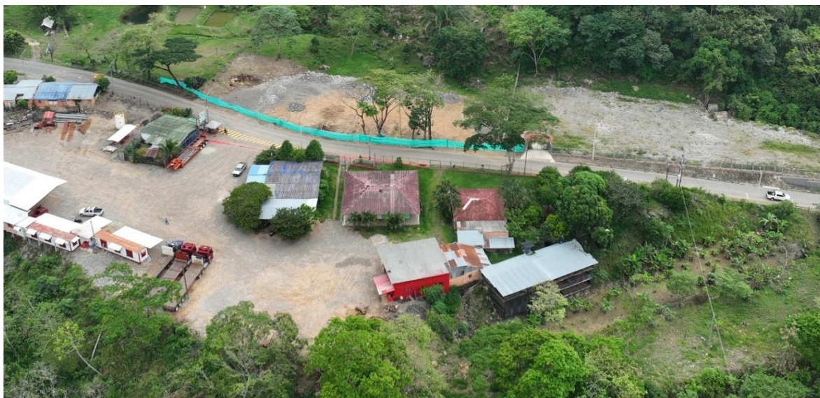
Foto 26 Afectación fajas reserva sector escuela La Guamalera. Cerramiento, excavaciones y explanaciones. Tubería de aducción de 18" y 16" coordenadas 5°25'17.377" N 72°26'52.117" W
