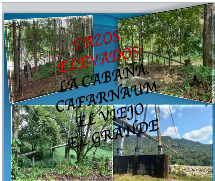
Foto 11 Pasos elevados sistema de acueducto.
