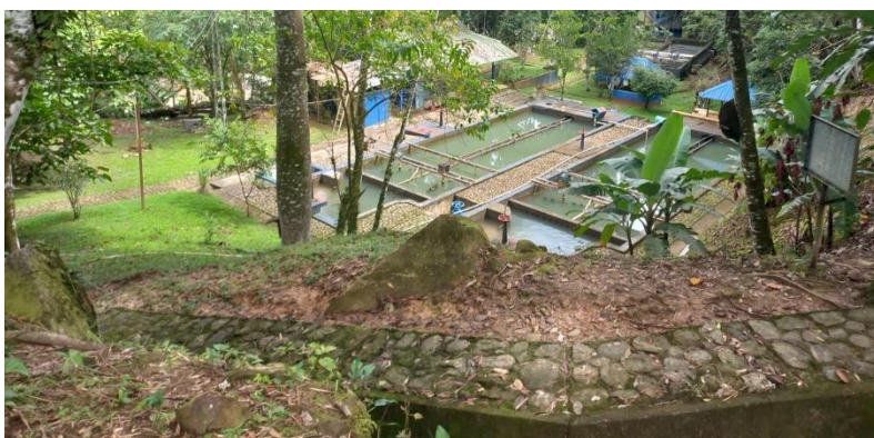
Foto 10 Sistema de desarenacion fuente la Tablona
