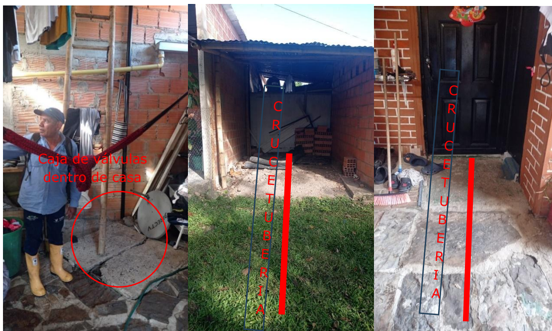
Foto 25 Edificaciones sobre la red y válvulas de acueducto.
