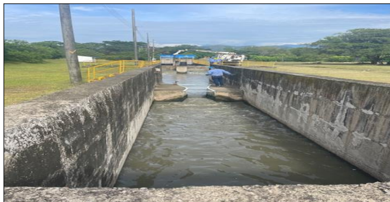
Imagen 14 Estructura de entrada a PTAR.
