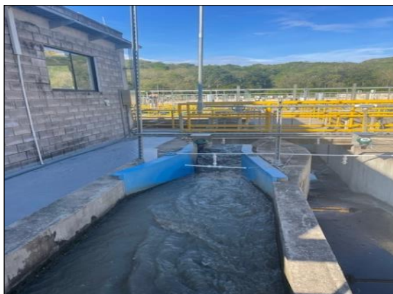
Imagen 1 Estructura de medición de entrada PTAP DEFINITIVA
