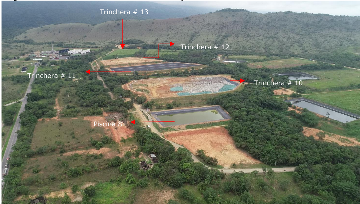
Imagen 30 Estado actual del Relleno Sanitario El Cascajar
