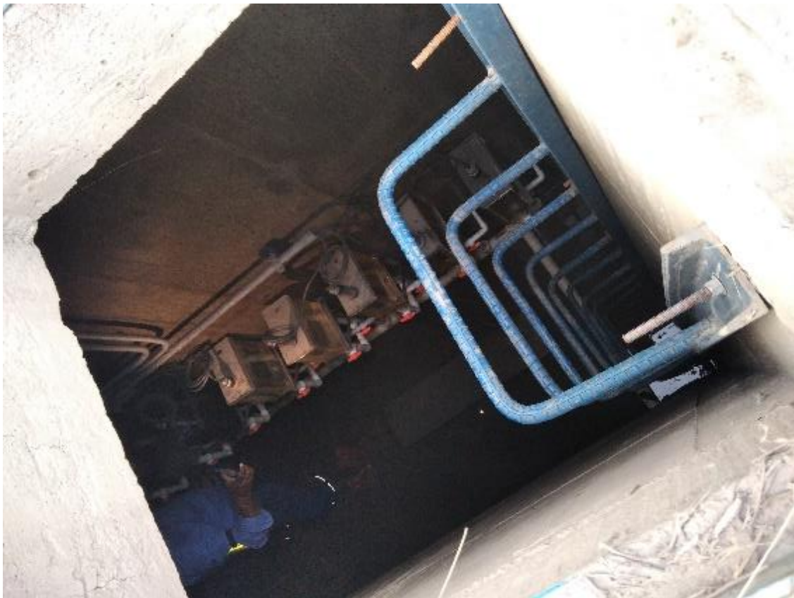
Imagen 8 Sensores de turbiedad, nunca han funcionado
