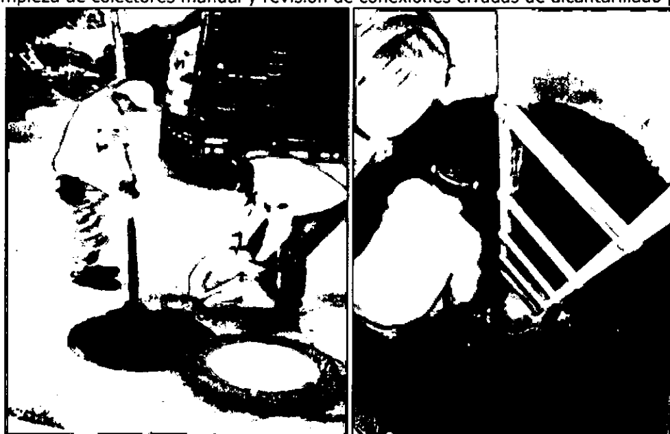
Figura: Limpieza de colectores manual y revisión de conexiones erradas de alcantarillado pluvial
