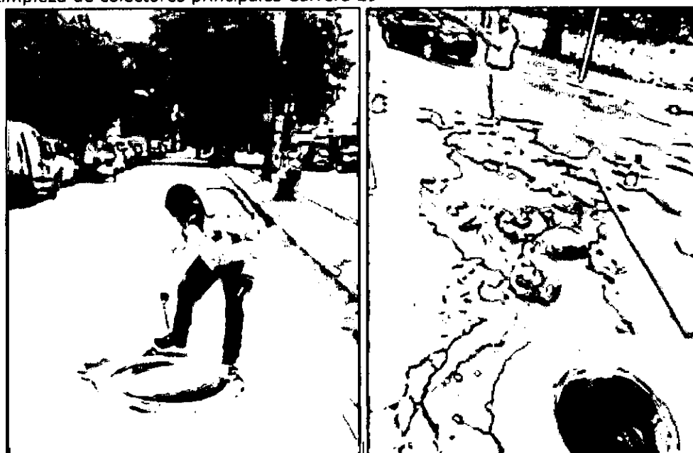
Figura: Utilización de Rotosonda manual y mecánica para solución de taponamiento en colectores.
