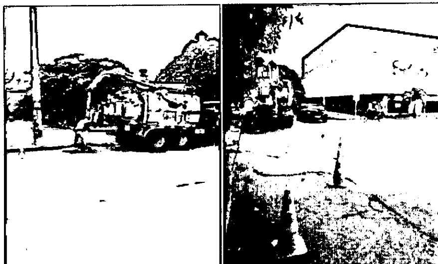
Figura: Limpieza de colectores principales Carrera 29
