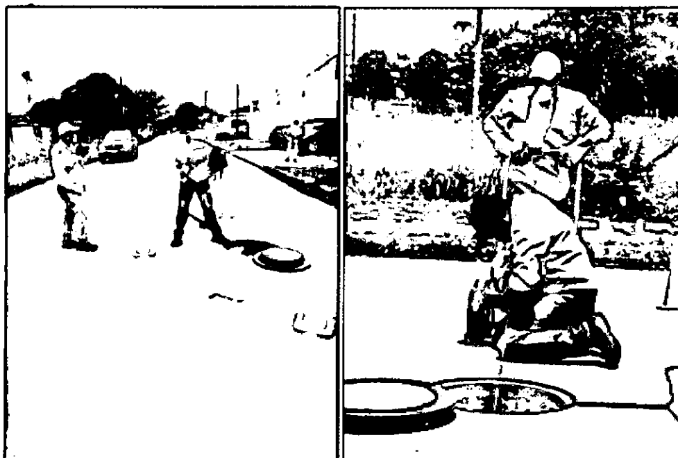
Figura: Limpieza de colectores manual y revisión de conexiones erradas de alcantarillado pluvial
