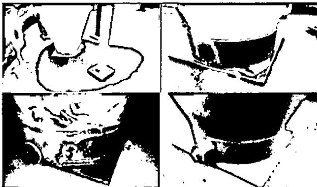
**Manga de Coleo:** El 31 de enero se intervino un hidrociclón el cual presentaba fuga por corrosión en la lámina inferior. Personal contratista retiró la base del hidrociclón, soldó las láminas y se corroboró que no hayan quedado fugas. Finalmente, se dio el acabado con la pintura.
