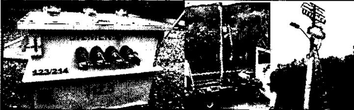
15 de agosto: Mantenimiento de transformador eléctrico central corrigiendo fallas de fugas de aceite, calentamiento.
