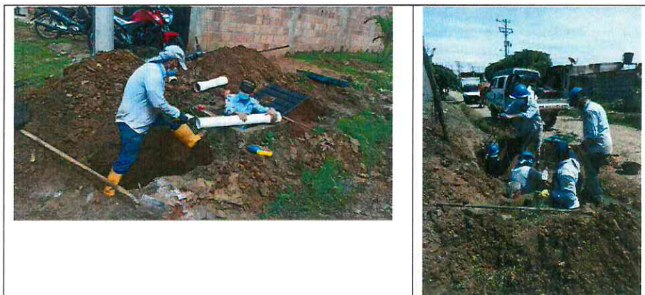
Cambio y reposición de Válvulas
