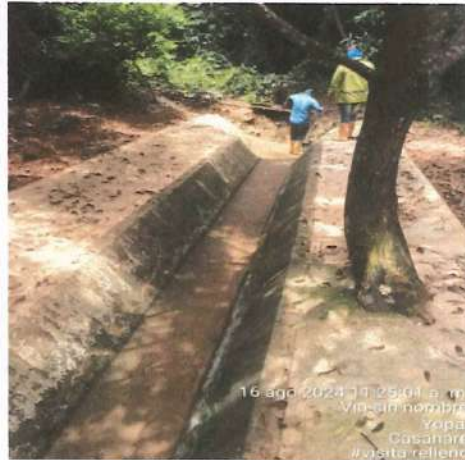
Limpieza de canales perimetrales.
