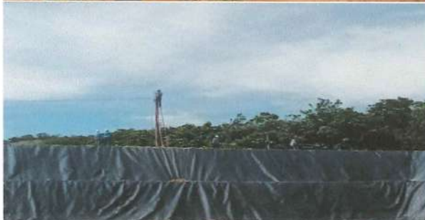
Instalación de Alumbrado trinchera #11 para inicio de operación, la cual ya se informó a CORPORINOQUIA.
