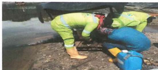
Instalación de electrobombas y motobomba para el secado de la trinchera #11.
