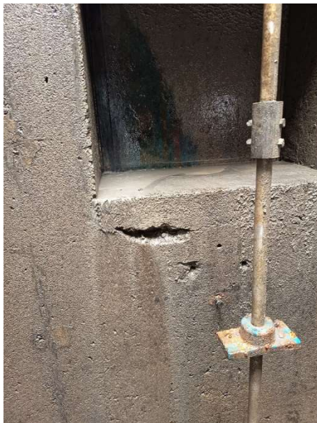
Foto 3 Mala adherencia de concreto
