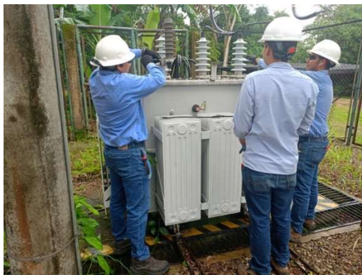
Fotografías 41 y 42: Se reemplaza DPS del transformador de 750 KVA de la PTAR.
