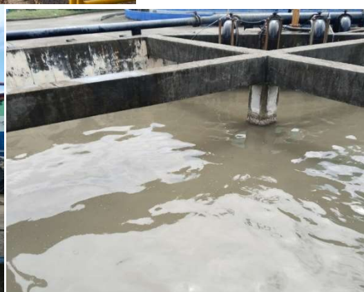
Fotografías 59 y 62: Actividad de extracción sobrenadantes en desarenadores, tanque de bombeo con apoyo de equipo succión.
