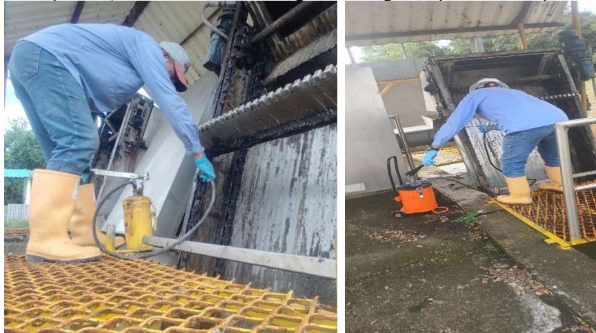
Fotografías 63 y 64: Engrase sistema autolimpiante.
