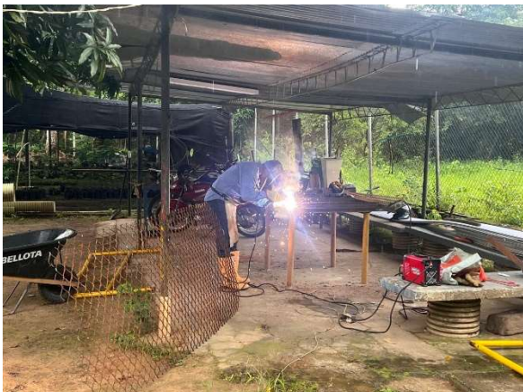
Fotografías 33-36: Soldadura, pintura e instalación pasarela izq del tren de desarenadores
