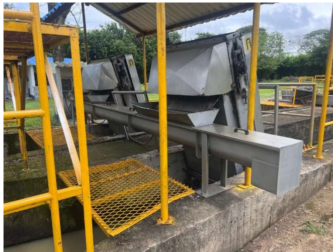
Fotografía 56 y 58: Retiro y limpieza de residuos sólidos en estructuras cribado manual y mecánico
