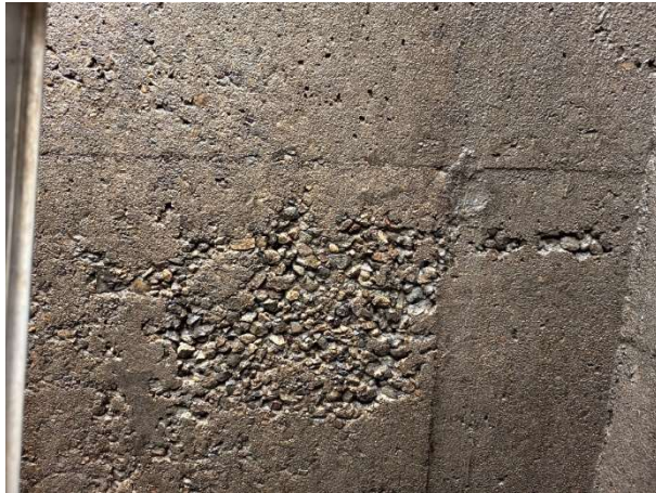
Foto 1 Segregación concreto
