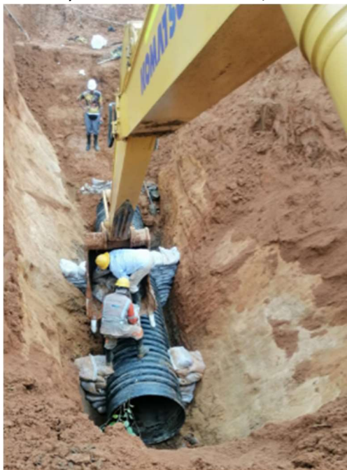
Fotografía N. 81 y 82: Actividades para la reparación de la tubería PEAD de 42" afectada por roturas y taponamiento.
