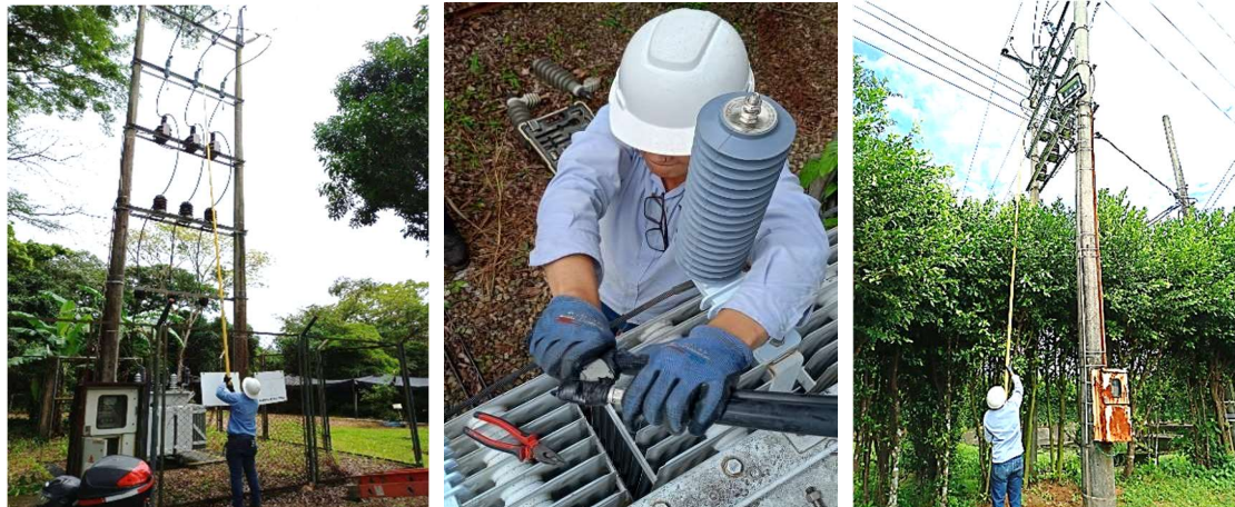
Fotografías 43 - 45: Mantenimiento correctivo en el transformador de 750 KVA y en herrajería del transformador de 112.5 KVA de filtros percoladores, se energiza nuevamente el circuito
