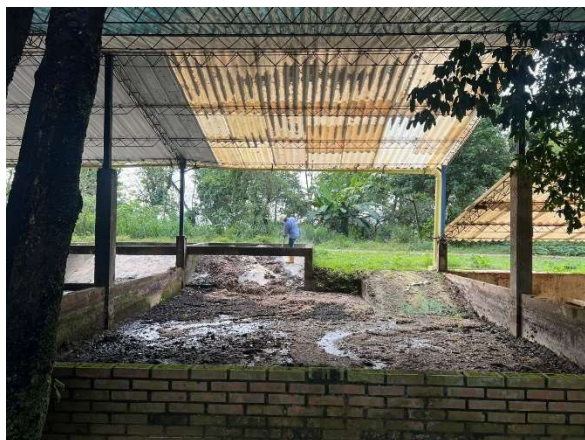
Fotografías 76-80: Deshidratación, volteo, retiro residuos sólidos y limpieza cámaras lechos de secado secos para disposición final
