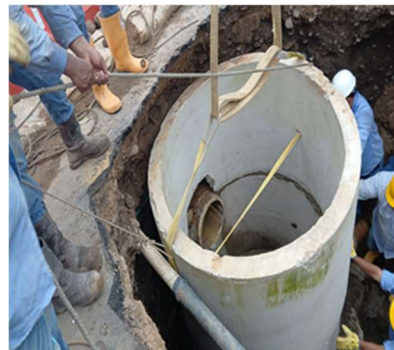
Foto3 Bombeo Aguas residuales Foto 4 Instalación cilindro pozo Foto 5 Reconstrucción pozo inspección
