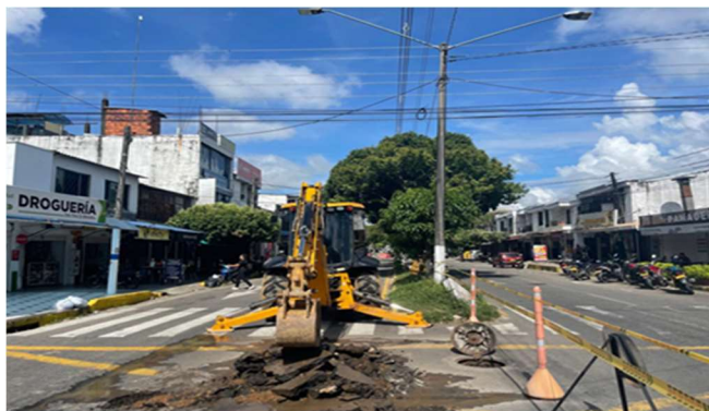
Foto 1 y 2 Afectacion pozo de inspeccion y tuberia de gress
