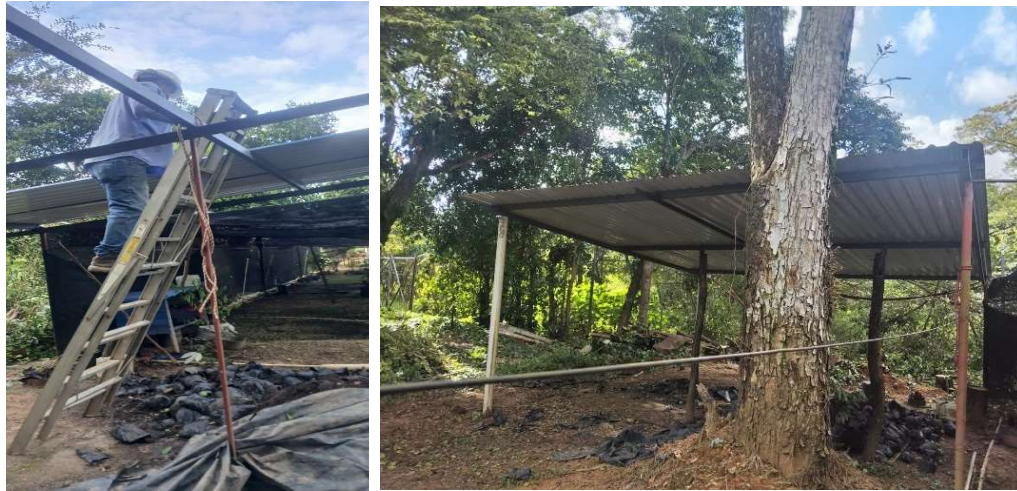
Fotografías 31 y 32: Adecuación estructura con techo de vivero
