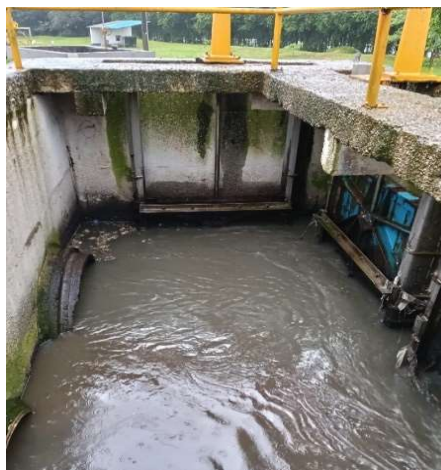
Fotografía 1. Cámara de entrada al sistema de tratamiento de aguas residuales
