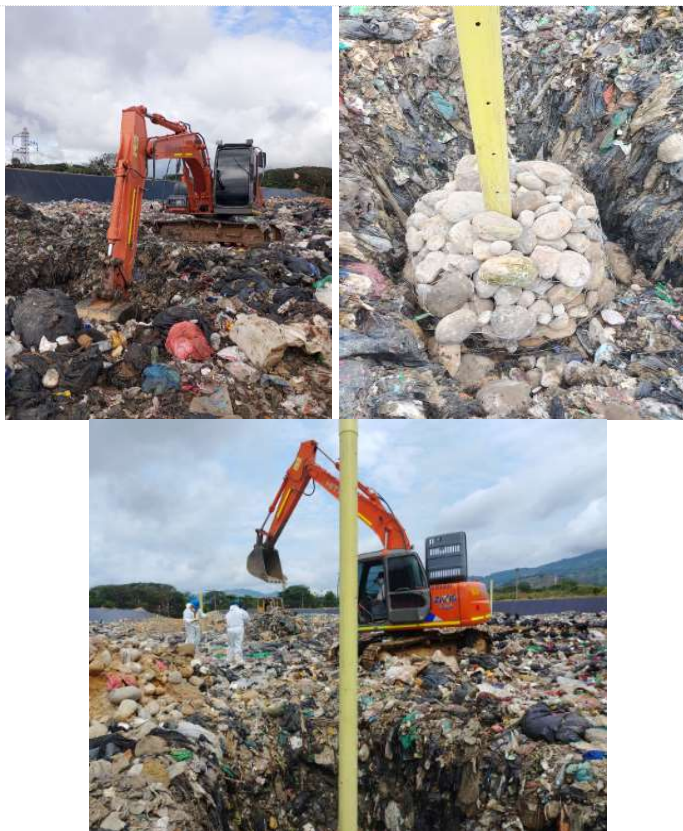
Construcción de chimeneas
