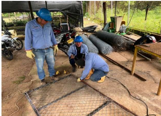
Fotografías 37 y 40: fabricación por autoconstrucción de portones para el acceso a las canaletas 18" y 36"
