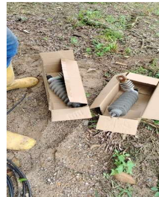
Fotografías 41 y 42: Se reemplaza DPS del transformador de 750 KVA de la PTAR.
