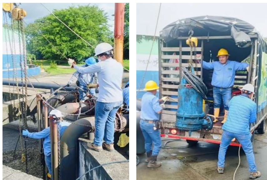
Fotografías 65 y 66: Retiro de bomba electro sumergible #5.
