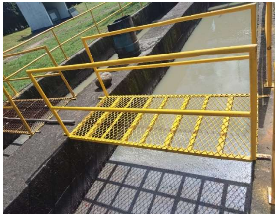
Fotografías 33-36: Soldadura, pintura e instalación pasarela izq del tren de desarenadores
