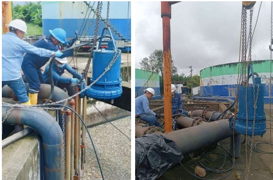
Fotografías 67 y 68: Instalación de bomba electro sumergible de repuesto en el puesto #5.
