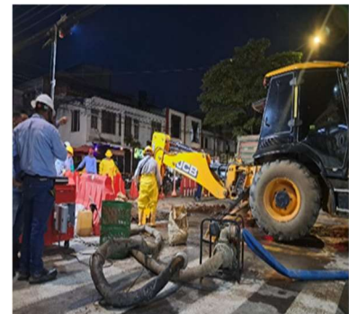
Foto3 Bombeo Aguas residuales Foto 4 Instalación cilindro pozo Foto 5 Reconstrucción pozo inspección
