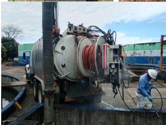
Fotografías 59 y 62: Actividad de extracción sobrenadantes en desarenadores, tanque de bombeo con apoyo de equipo succión.
