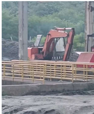
Mantenimientos realizados en el mes de Agosto/2025 con máquina retroexcavadora para la extracción de material en bocatoma
