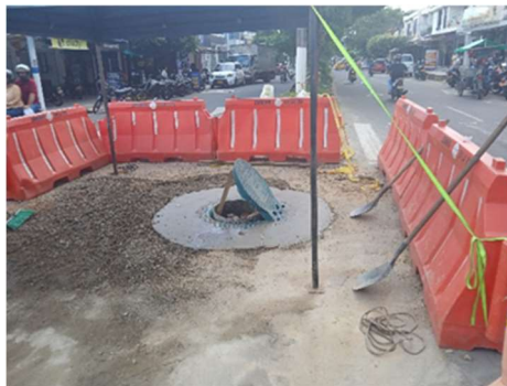
Foto3 Bombeo Aguas residuales Foto 4 Instalación cilindro pozo Foto 5 Reconstrucción pozo inspección
