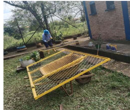
Fotografías 37 y 40: fabricación por autoconstrucción de portones para el acceso a las canaletas 18" y 36"
