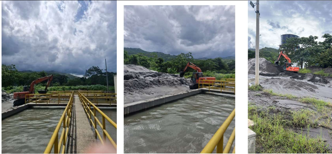
Mantenimientos realizados en el mes de Agosto/2025 con máquina retroexcavadora para la extracción de material en bocatoma
