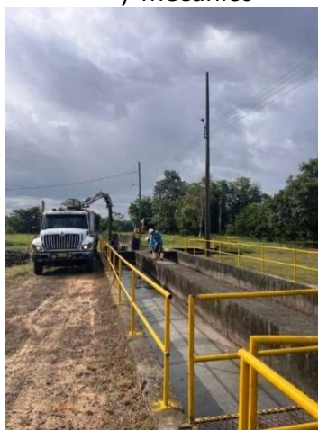
Fotografía 56 y 58: Retiro y limpieza de residuos sólidos en estructuras cribado manual y mecánico
