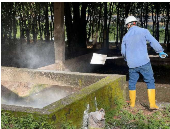
Fotografías 76-80: Deshidratación, volteo, retiro residuos sólidos y limpieza cámaras lechos de secado secos para disposición final
