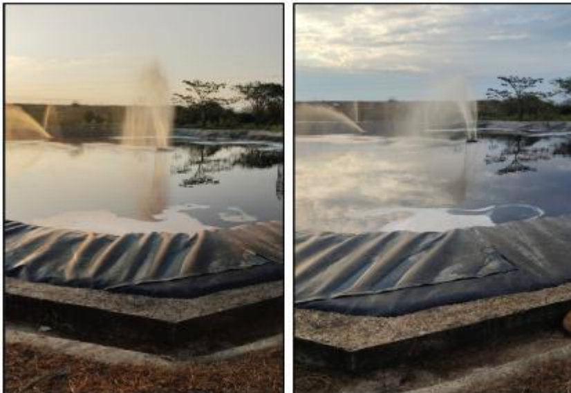
Ilustración 31 Aspersión de agua con lixiviados mediante bombeo tipo fuente (Microburbuja)
