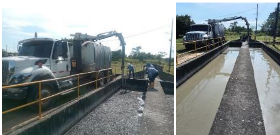
Fotografías 44 y 45: Actividad de extracción sobrenadantes en desarenadores con apoyo de equipo succión
