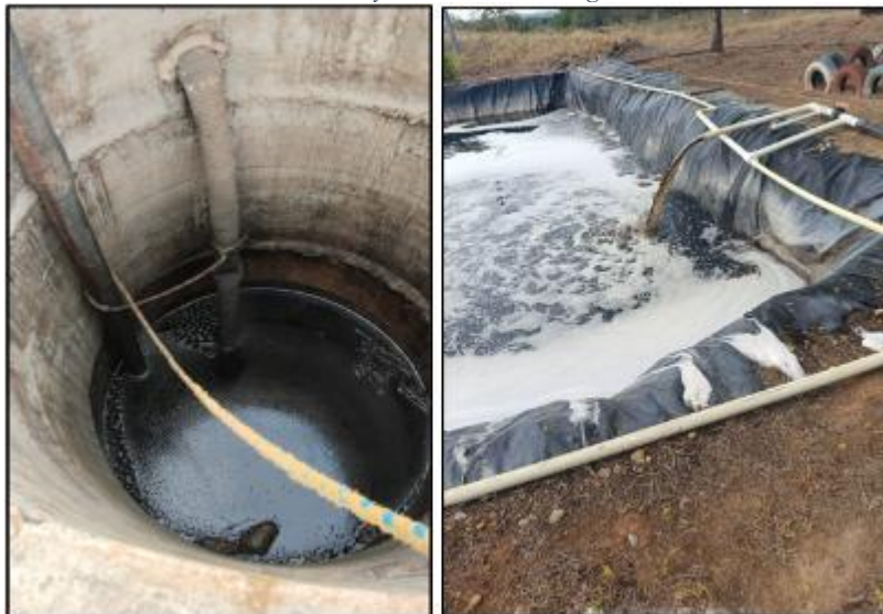
Ilustración 32 Bombeo y recirculación de agua con lixiviados
