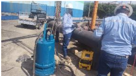
Fotografías 37 – 39. Instalación de electrobomba en el puesto #5 traída por garantía con serie 51949.
