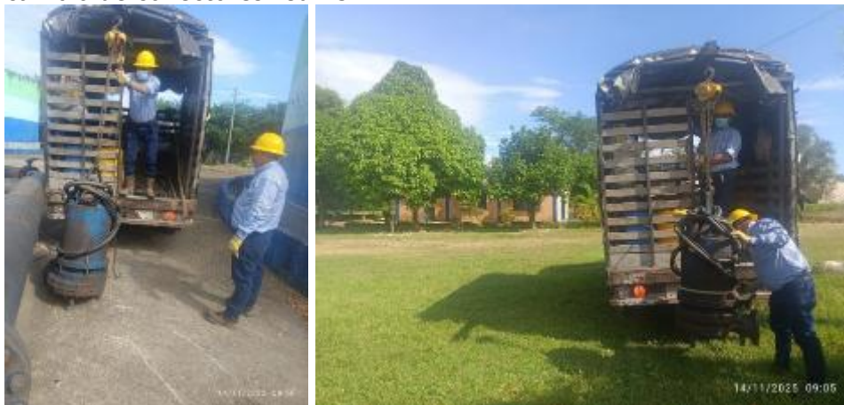
Fotografías 30 y 31. Traslado de electrobomba retirada por falla frente al laboratorio
