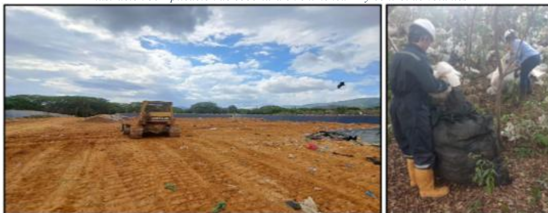
Ilustración 35 Aplicación de cobertura en chimenea 11 y control de volantes
