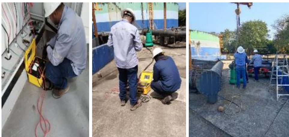
Fotografías 34 – 36. Revisión falla arrancador electrobomba #5 serial 503313003 queda fuera de servicio.
