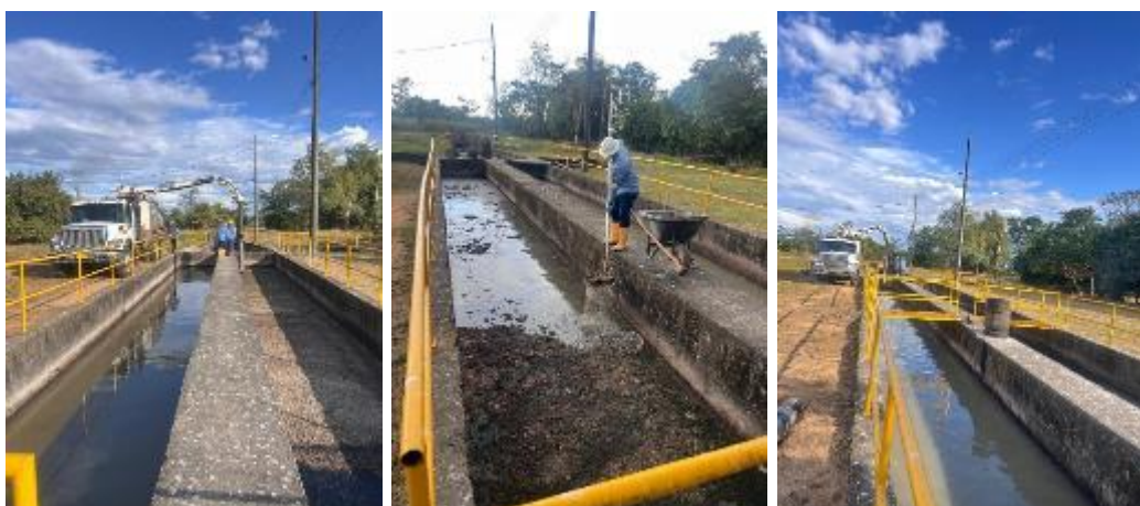
Fotografías 46 - 48: Actividad de extracción sobrenadantes en desarenadores con apoyo de equipo succión
