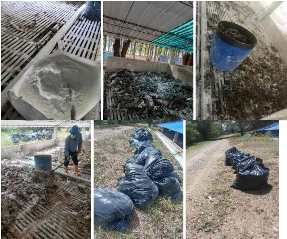
Fotografías 62-65: Deshidratación, volteo, retiro residuos sólidos y limpieza cámaras lechos de secado secos para disposición final
