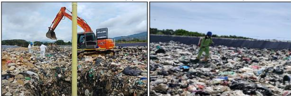
Ilustración 34 Mantenimiento a chimeneas y aplicación de bio insumos para control de olores y vectores.
