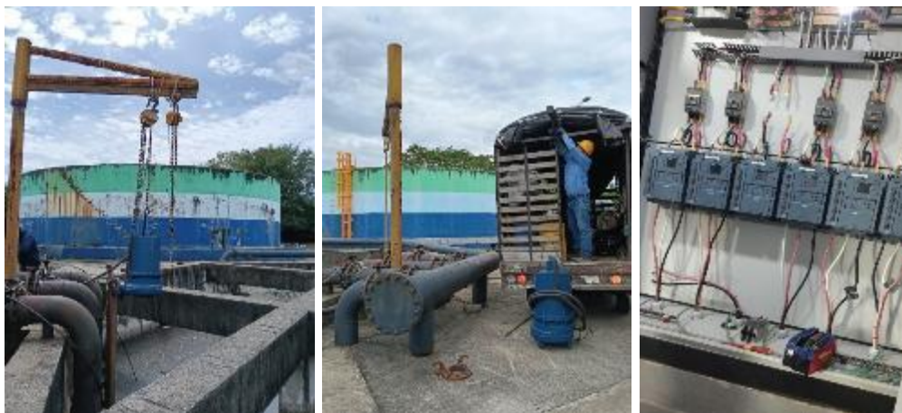
Fotografías 24 - 26. Traslado y cambio de breaker de electrobomba por garantía serial # M39458 la cual se instala en el puesto #3.
