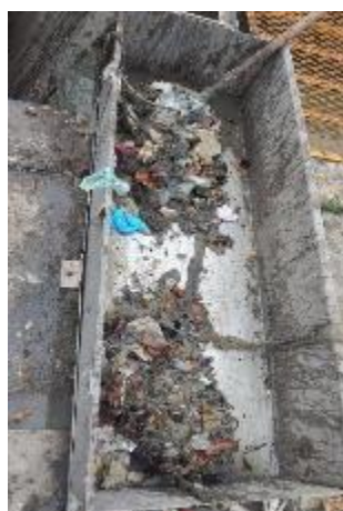
Fotografía 40 - 43: Retiro y limpieza de residuos sólidos en estructuras cribado manual y mecánico
