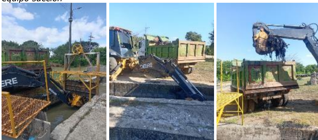
Fotografías 46 - 48: Actividad de extracción sobrenadantes en desarenadores con apoyo de equipo succión
