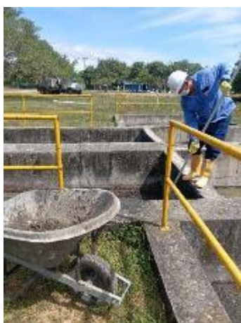
Fotografía 40 - 43: Retiro y limpieza de residuos sólidos en estructuras cribado manual y mecánico
