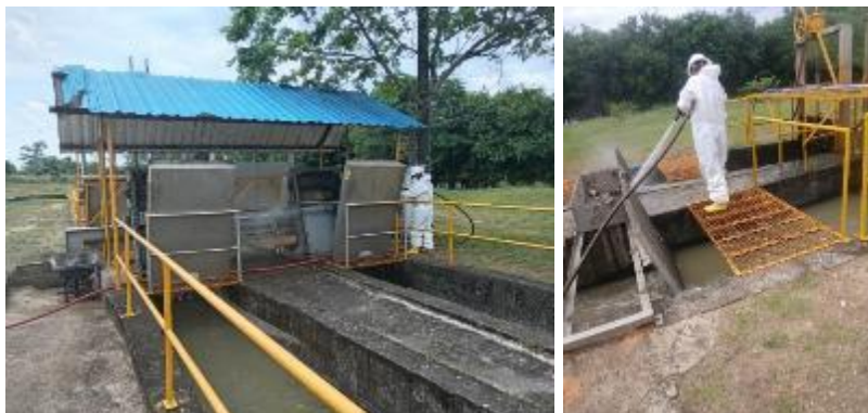
Fotografías 52 y 53: lavado y limpieza cribado manual y mecánico
