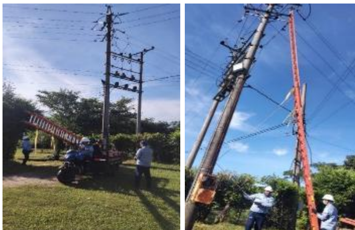
Fotografías 20 y 21. Apoyo revisión de falla eléctrica en la red interna 13.5 kW
