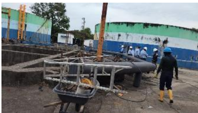
Fotografías 22 y 23. Instalación de electrobombas en los puestos 5 y 6
