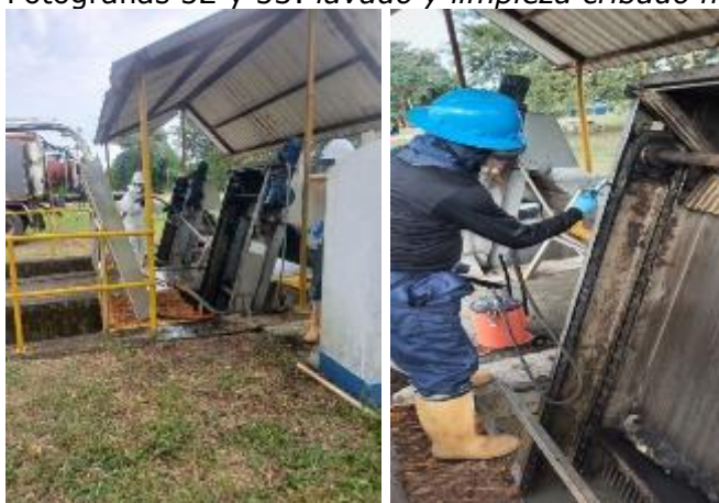
Fotografías 54 y 55: Engrase sistema autolimpiante.
