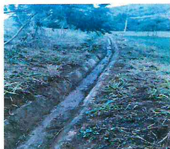
Canales perimetrales Manejo de Aguas Lluvia
