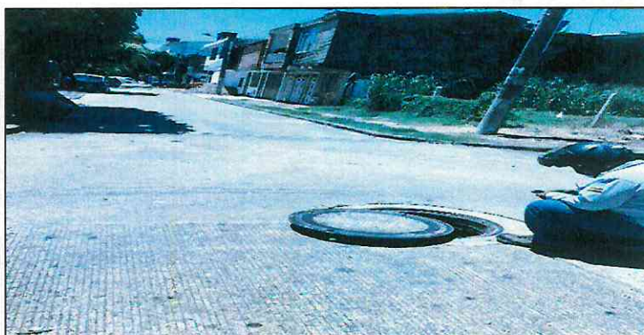
Imagen 17. Levantamiento de las redes nuevas y existentes de sistema de acueducto y alcantarillado sanitario.
