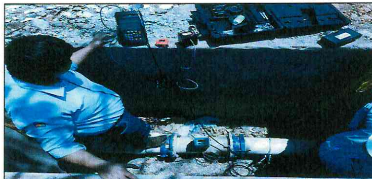
Imagen 19. Acompañamiento a la Unidad de Acueducto puesta en marcha de macromedidor de 8".
