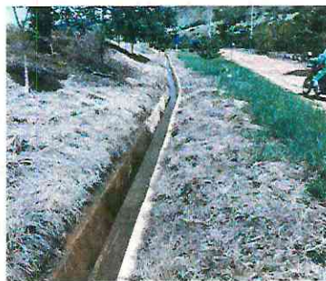
Canales perimetrales Manejo de Aguas Lluvia
