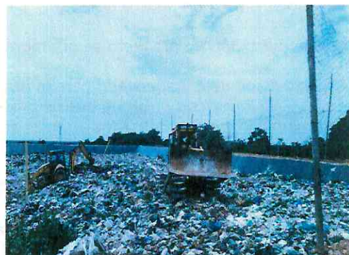
Compactación, dispersión de residuos en la trinchera No. 12
