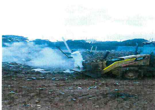
Aplicación de agente biológico en trinchera
