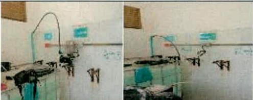
Se realiza retiro de electrobomba dosificadora de cloro del pozo núcleo 2 con destino a planta alterna
