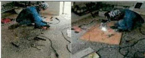
Se realiza construcción de base para bomba dosificadora que va a ser instalada en planta conciliada
