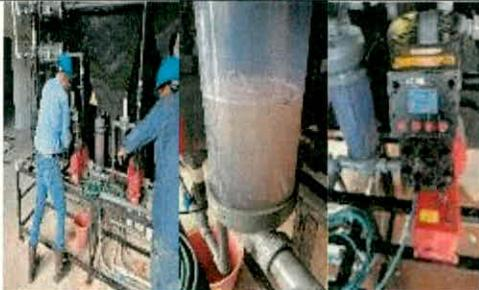
Se realiza mantenimiento correctivo en electrobomba de PAC #1 se realiza limpieza del diafragma y de la tubería de descarga queda operando en orden
