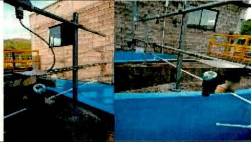
Se desinstala sensor de nivel de la canaleta central y se instala en la canaleta 2 queda registrando parámetros normales
