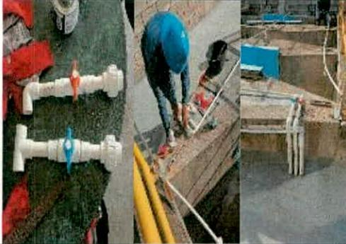
Se realiza ensamble de accesorios para realizar by pass en las electrobombas de PAC en la descarga de canaleta parshall
