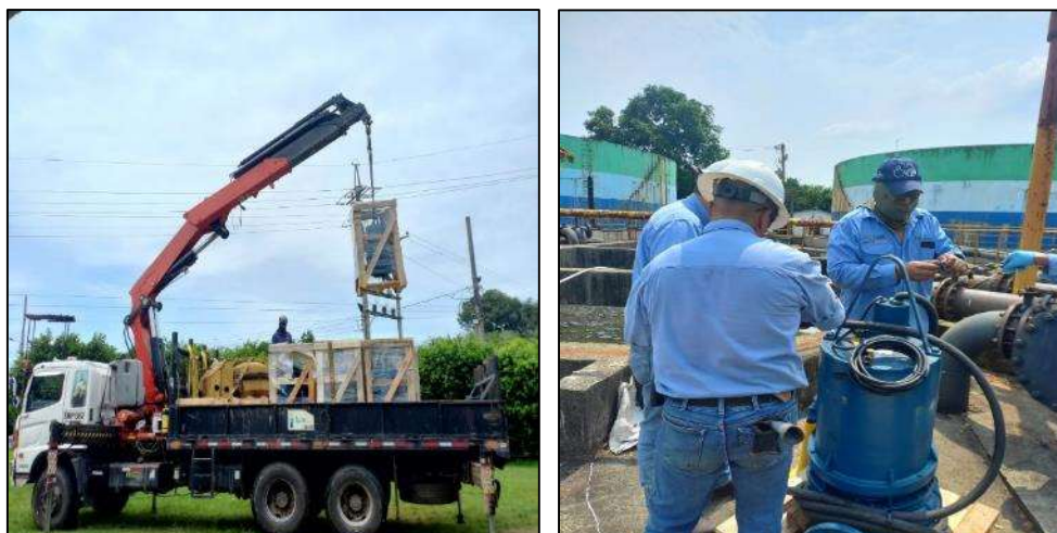
Ilustración 18 • Instalación de 06 bombas sumergibles
