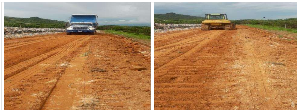
Ilustración 20 Jarillón / Dique Trinchera 10
