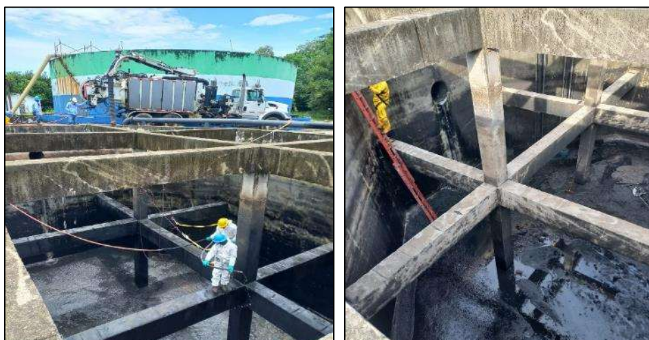
Ilustración 17 • Retiro de lodos tanque de bombeo
