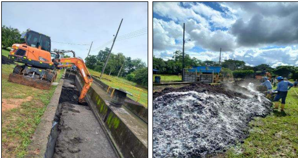
Ilustración 15 • Retiro de sedimentos desarenador.
