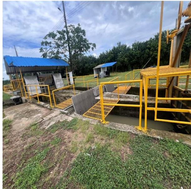
Imagen 1 y 2. (Izq) Cámara de Entrada (capacidad máx 600 l/s) y (Der) Pretratamiento (Zona de Cribado manual y mecánico).
