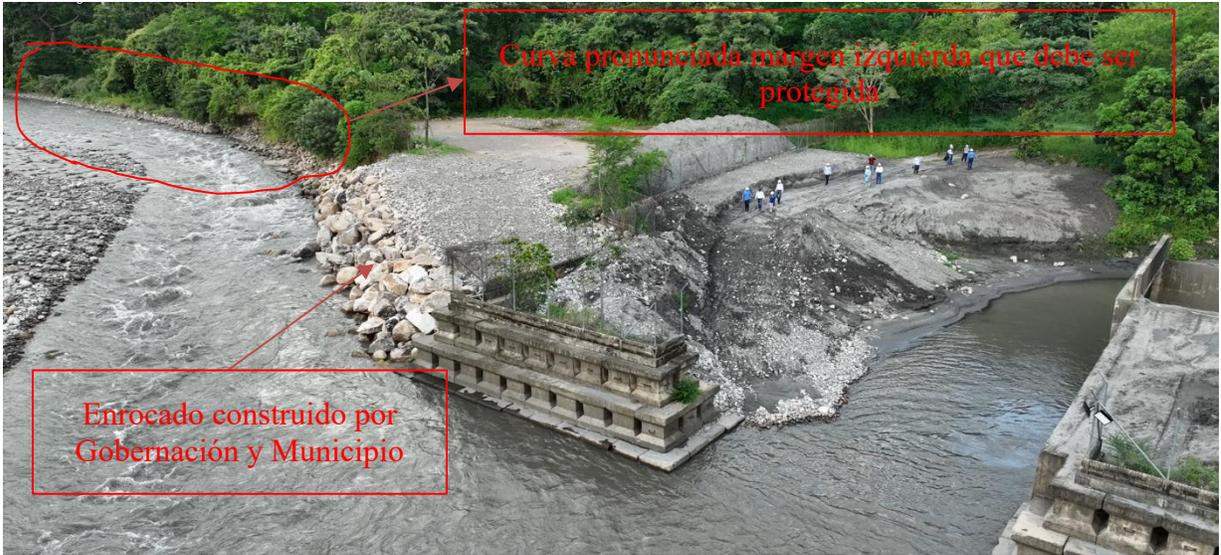
Foto 2 Tomada en octubre de 2024 - Obras de Protección - Enrocado
