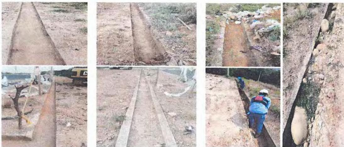
Foto 32 Limpieza de canales perimetrales trincheras 10 y 11
