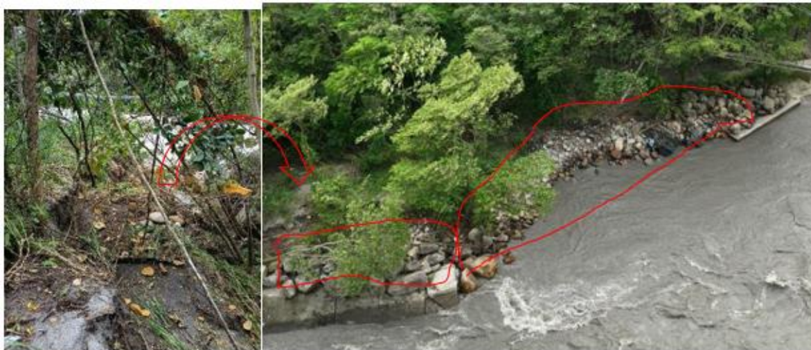
Incremento considerable de socavación y destrucción de Gaviones revestidos
