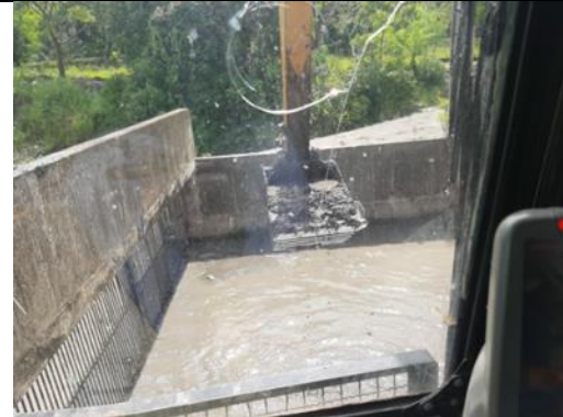
Mantenimientos realizados en el mes de Octubre/2025 con máquina retroexcavadora para la extracción de material en desarenadores
