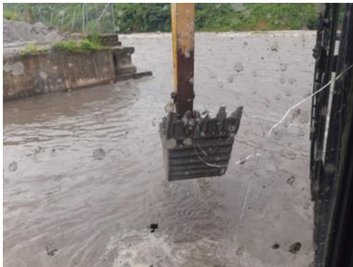
Mantenimientos realizados en el mes de Octubre/2025 con máquina retroexcavadora para la extracción de material en desarenadores
