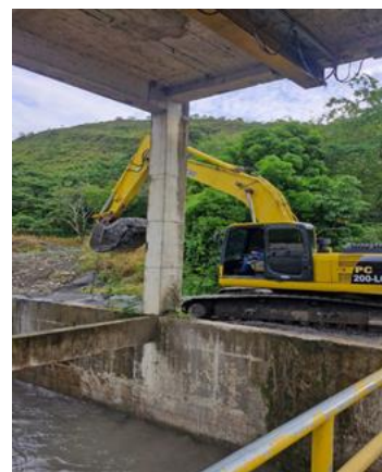
Mantenimientos realizados en el mes de Octubre/2025 con máquina retroexcavadora para la extracción de material en bocatoma
