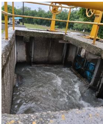
Izq. Cámara de entrada al sistema de tratamiento de aguas residuales. Der: Vertimiento Aguas Residuales Tratadas.
