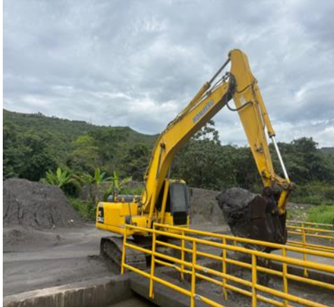
Mantenimientos realizados en el mes de Octubre/2025 con máquina retroexcavadora para la extracción de material en bocatoma
