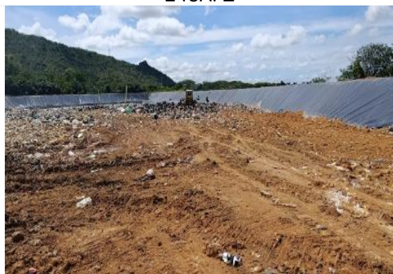
Cobertura con material trinchera en operación 11
