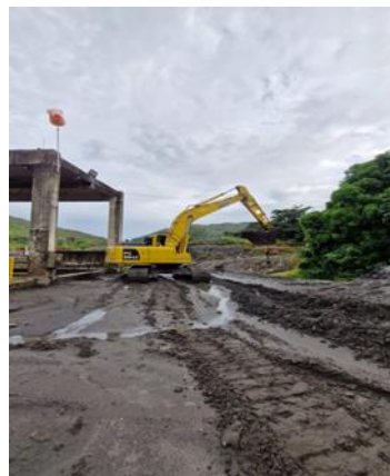
Mantenimientos realizados en el mes de Octubre/2025 con máquina retroexcavadora para la extracción de material en bocatoma
