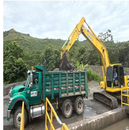
Mantenimientos realizados en el mes de Octubre/2025 con máquina retroexcavadora para la extracción de material en bocatoma
