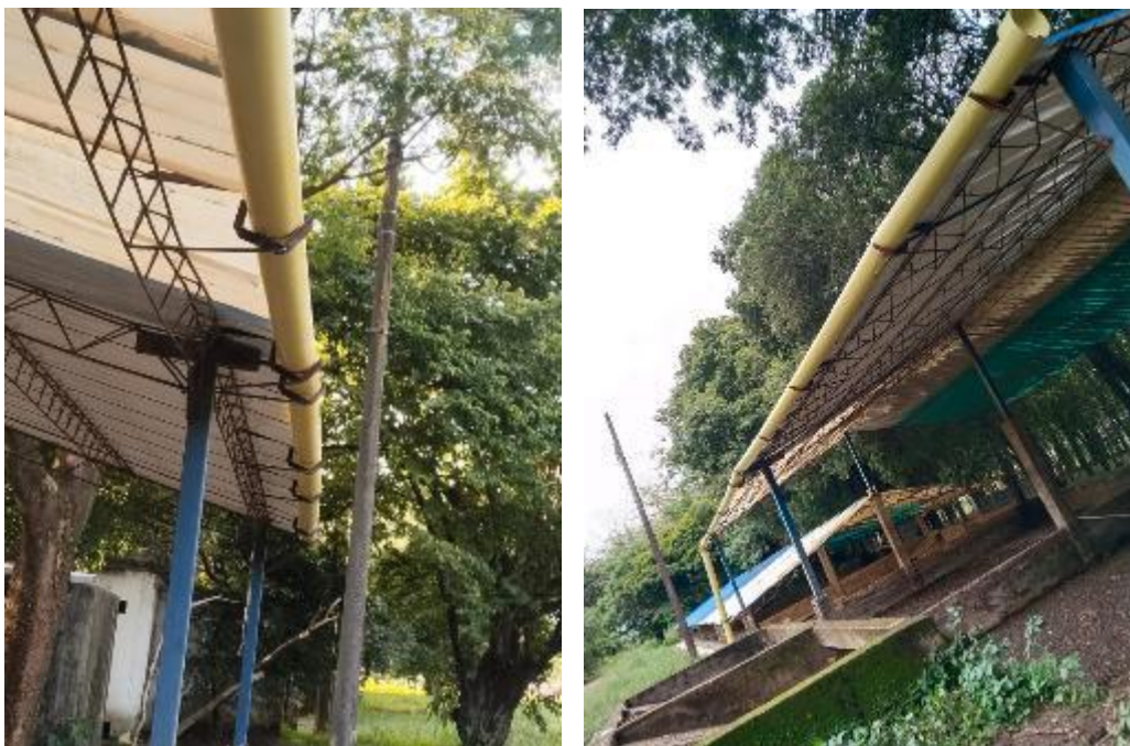
Fotografía 62 y 63: Construcción de canales perimetrales en lechos de secado.
