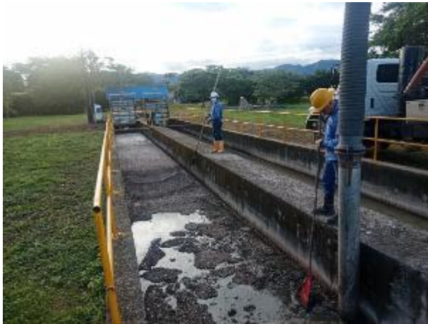
Fotografías 36 y 37: Actividad de extracción sobrenadantes en desarenadores con apoyo de equipo succión
