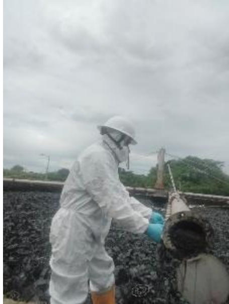
Fotografías 50 y 51: limpieza de residuos que obstruyen los orificios de las flautas, garantizando un flujo adecuado del agua
