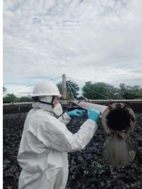
Fotografías 50 y 51: limpieza de residuos que obstruyen los orificios de las flautas, garantizando un flujo adecuado del agua
