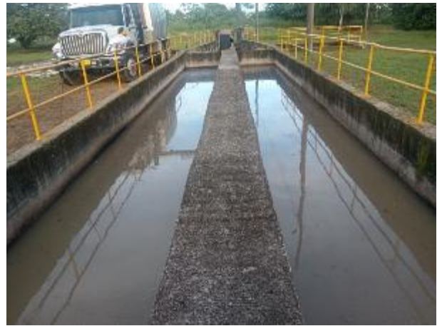
Fotografías 36 y 37: Actividad de extracción sobrenadantes en desarenadores con apoyo de equipo succión
