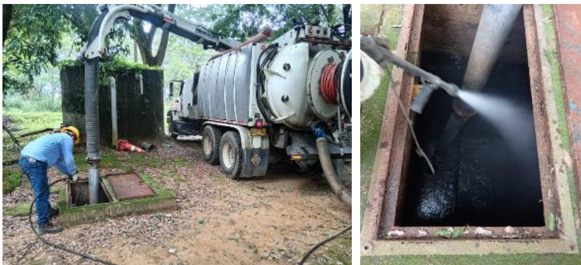
Fotografía 60 y 61: mantenimiento preventivo del tanque sistema de drenaje cámaras de lechos de secado.
