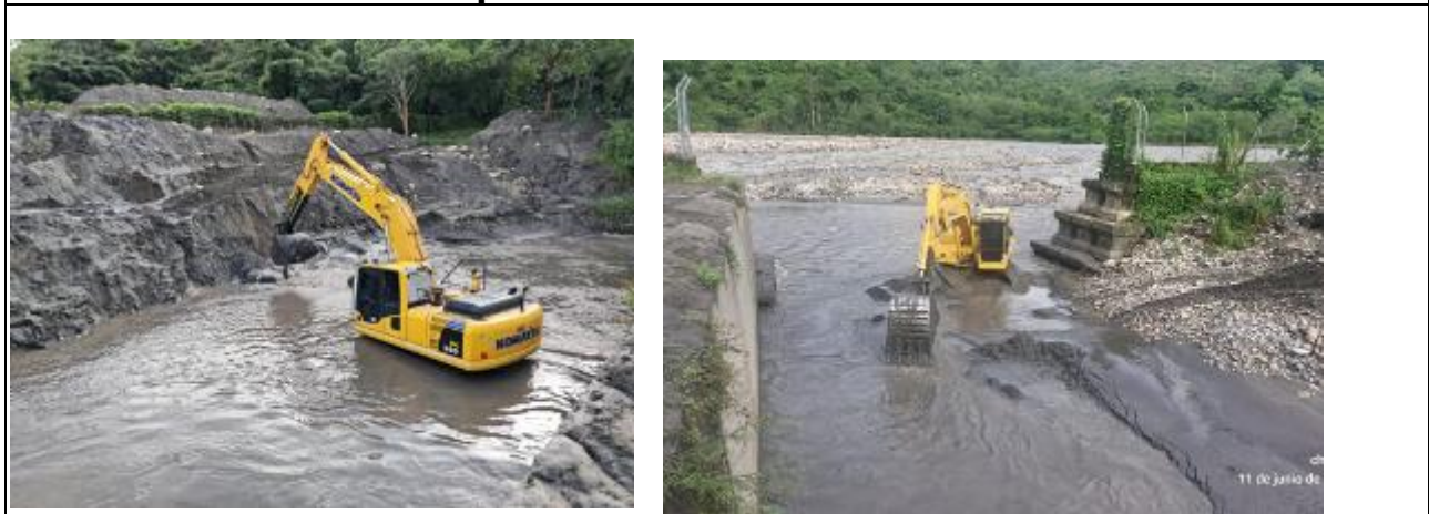
Mantenimientos realizados en el mes de Junio/2025 con máquina retroexcavadora para la extracción de material en bocatoma
