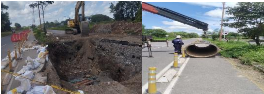
Fotos atención emergencia - reparación tubería.
