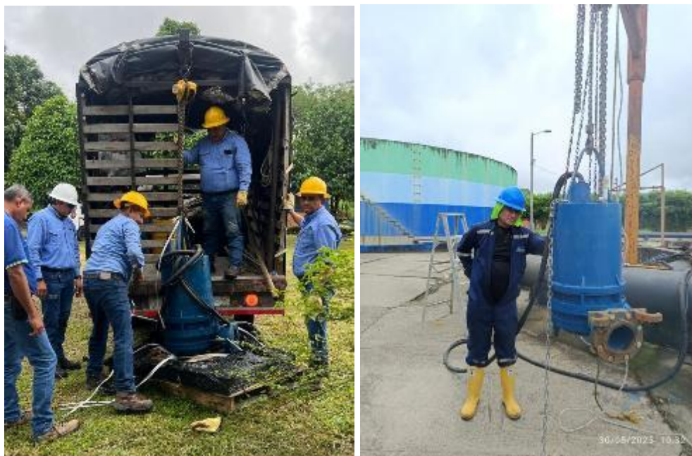
Fotografías 44 y 45: Recibo e instalación de bomba electro sumergible.
