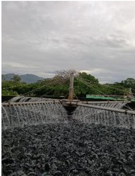
Fotografías 46 - 49: limpieza de residuos que obstruyen los orificios de las flautas, garantizando un flujo adecuado del agua
