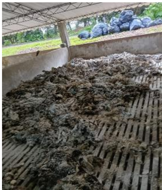
Fotografías 52-55: deshidratación, volteo y retiro de lodos secos para disposición final
