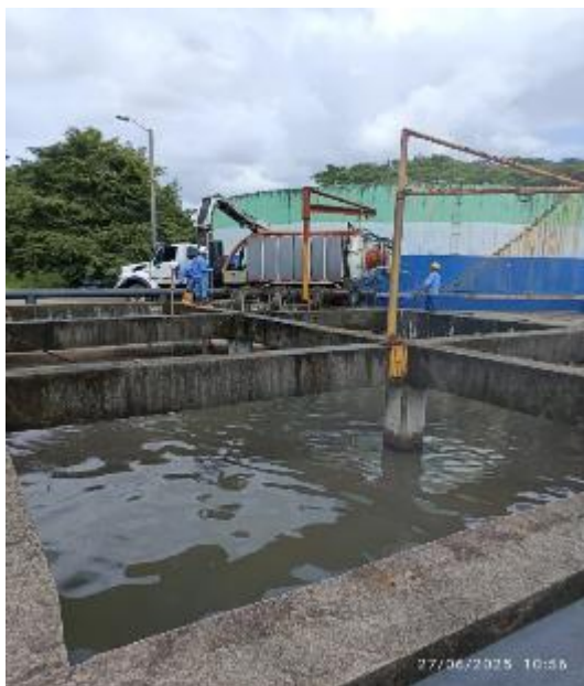
Fotografías 42 y 43: Extracción de sobrenadantes con apoyo de equipo de succión y lavado de bandejas filtro percoladores.
