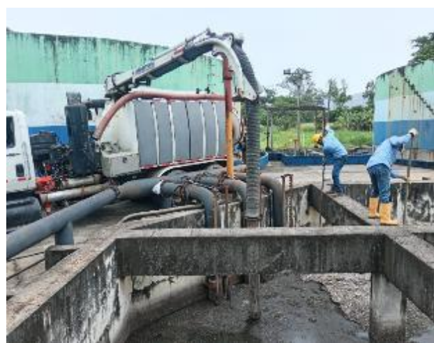
Fotografías 40 y 41: Extracción con apoyo de equipo de succión y limpieza tanque de Bombeo
