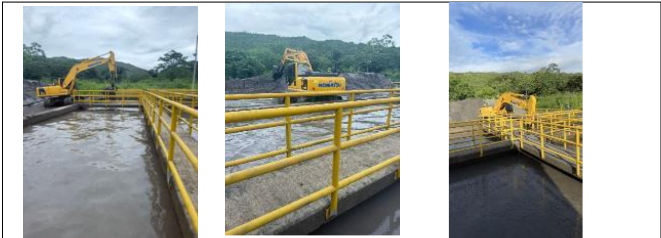
Mantenimientos realizados en el mes de Junio/2025 con máquina retroexcavadora para la extracción de material en bocatoma
