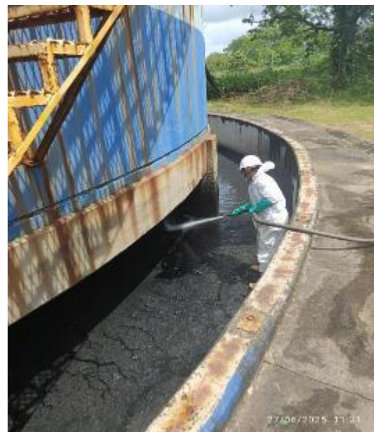
Fotografías 42 y 43: Extracción de sobrenadantes con apoyo de equipo de succión y lavado de bandejas filtro percoladores.
