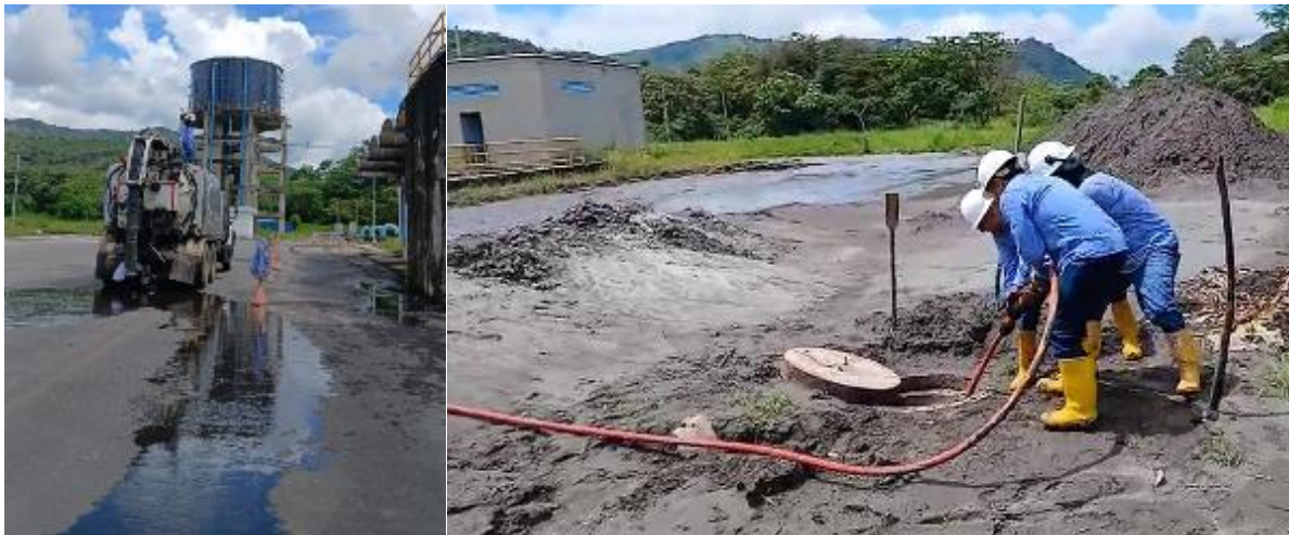
Limpieza de redes con camión presión succión
