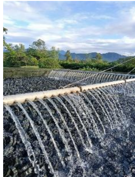
Fotografías 46 - 49: limpieza de residuos que obstruyen los orificios de las flautas, garantizando un flujo adecuado del agua
