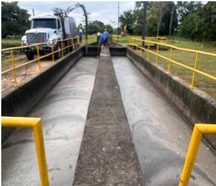
Fotografías 38 y 39: Actividad de extracción sobrenadantes en desarenadores con apoyo de equipo succión
