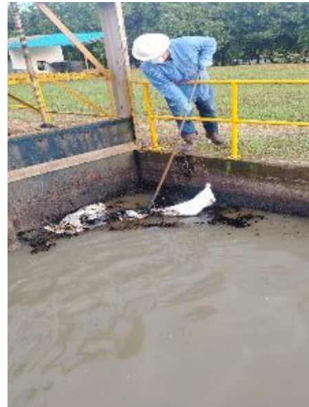
Fotografías 30 y 31: Actividad de extracción sobrenadantes en desarenadores con apoyo de equipo succión
