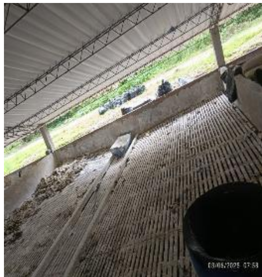
Fotografías 52-55: deshidratación, volteo y retiro de lodos secos para disposición final
