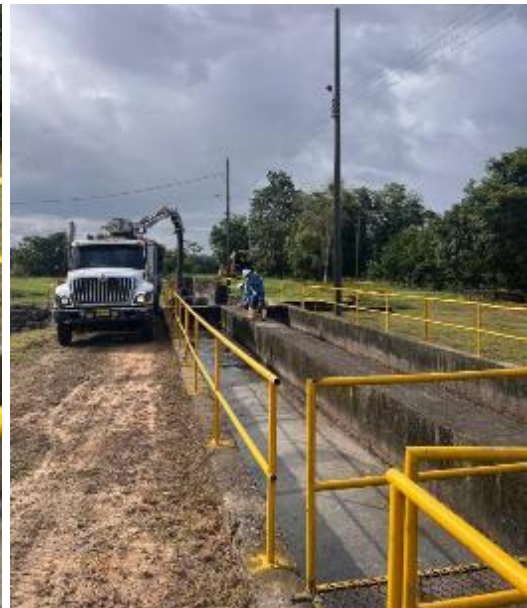
Fotografías 38 y 39: Actividad de extracción sobrenadantes en desarenadores con apoyo de equipo succión
