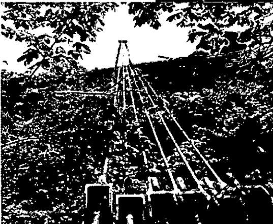
Foto. Cable diámetro 1-7/8" IPS 7 IRWC 6x19 o 6x37 galvanizado (antes del hurto)
