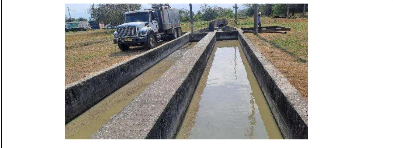
*Extracción con apoyo de equipo de succión y limpieza tanque de Bombeo*
