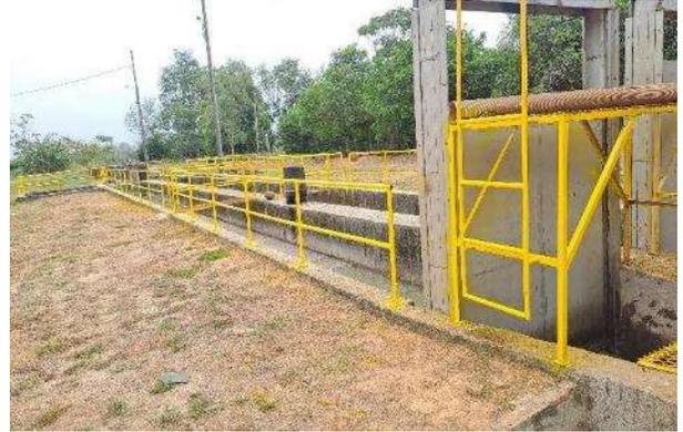
*Estado actual totalidad estructura metálica desarenadores reparada, pintada e instalada.*
