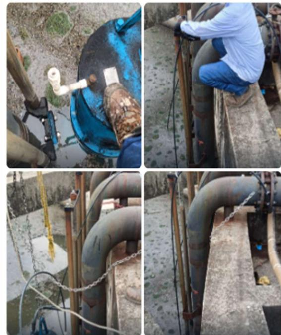
Se realiza adaptación de desfogue de aire en válvula de alivio de electrobomba sumergible 1 y 2 de filtros percoladores en ptar
