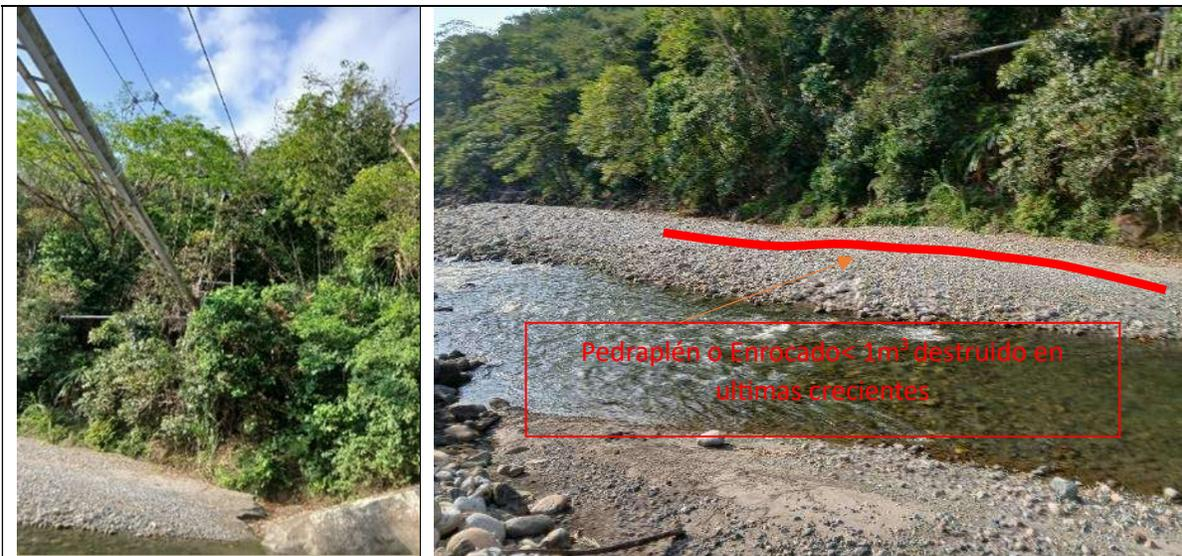
Foto Sector de obra de protección completamente destruida en longitud de 69m costado derecho - paso elevado Cafarnaúm
