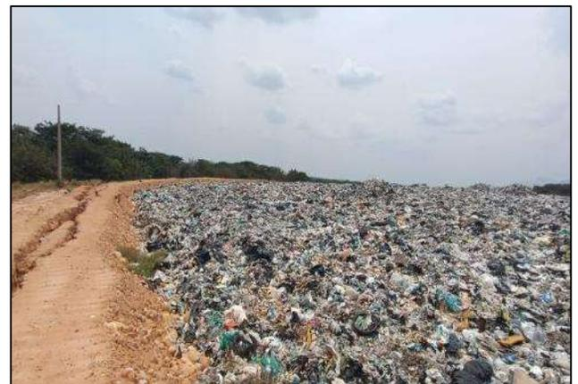
**La trinchera No. 11**, inicio operación el 20 de octubre de 2024, se muestra información de las condiciones de diseño. La celda cuenta con alumbrado, canales perimetrales, acceso en buenas condiciones que permite la operación normal.
