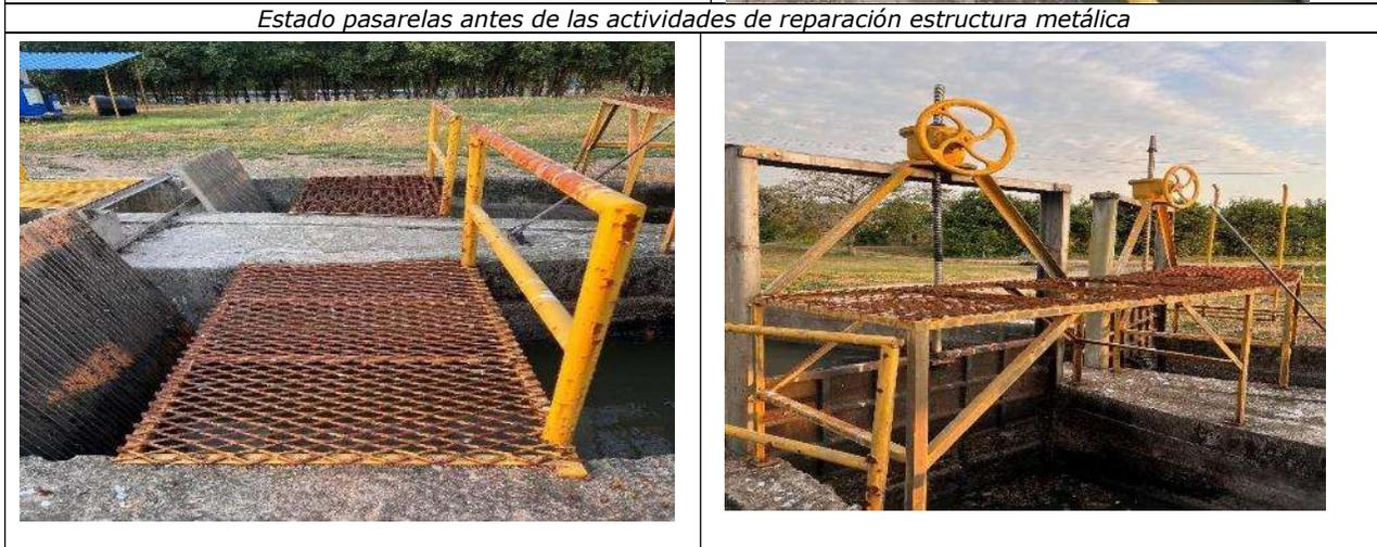
*Estado actual de las actividades de reparación estructura metálica (fabricación, soldadura, pintura e instalación estructura metálica zona de cribado manual y mecánico.*
