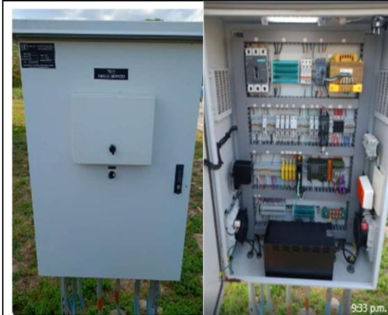
Se realiza mantenimiento preventivo al gabinete de centro de control de motores de bombas de agua de servicio
