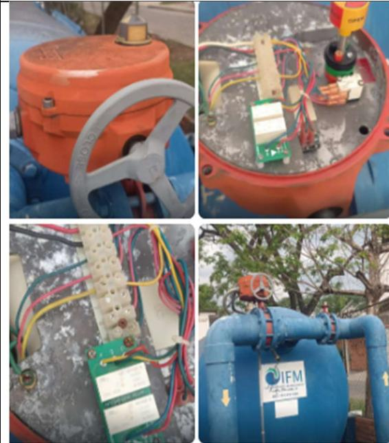
Se realiza retiro de electro válvula de filtro 3 del pozo central de abastos para manteniendo ya que se encuentra frenada
