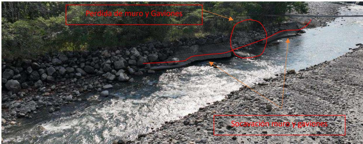
Foto Estructuras de protección afectadas margen izquierda paso elevado Cafarnaum.
