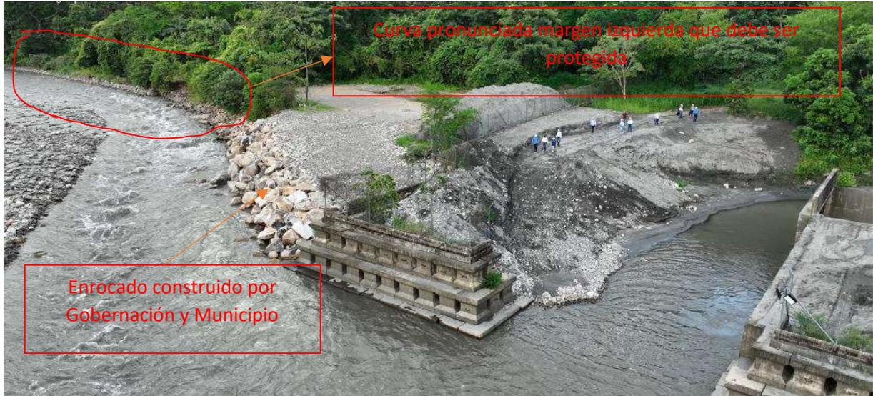
**Foto 70** . tomada en octubre de 2024 - Obras de Protección - Enrocado
