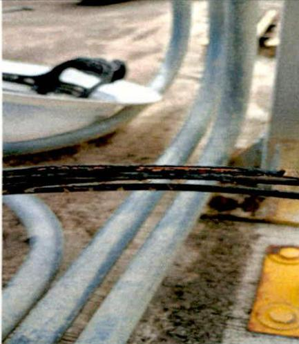
se realiza mantenimiento correctivo en circuito que energiza el tablero tp04 debido a que presentaba cortó circuito después de realizar el respectivo mantenimiento se energiza y queda operando en orden
