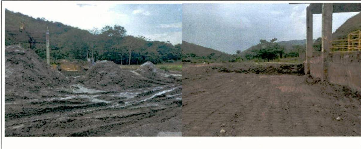
En condiciones climáticas de altas precipitaciones y bajas precipitaciones es importante contar con el apoyo de una máquina retroexcavadora debido a que el afluente es susceptible a modificaciones de cauce y niveles del Río; en niveles altos se presenta gran acumulación de material lo cual es necesario extraer el material sedimentado y en niveles bajos se debe garantizar la derivación del flujo de agua hacia la estructura de captación.
