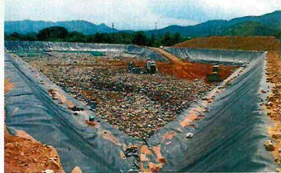
Compactación, dispersión y cubrimiento con arcilla de residuos en la trinchera No. 12
