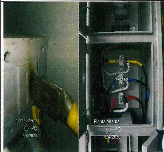
Mantenimiento correctivo tres TC, de equipo de medida clase 0.5S ACE6000 Itron / No. 59006056, los cuales presentaron recalentamiento por Termoconducción y la unidad de pérdidas de la empresa de Enerca recomendó que se debían reemplazar.
