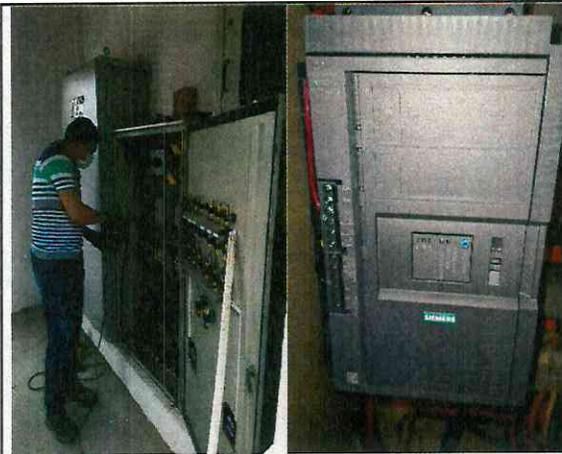
Mantenimiento preventivo subestación y tablero de control y potencia e instalación de arrancador suave de referencia 3RW5226-1AC14 \*E01\* V2.0.1, Ie: 77A <= 40°C, 460V. de electrobombas de filtros percoladores.
