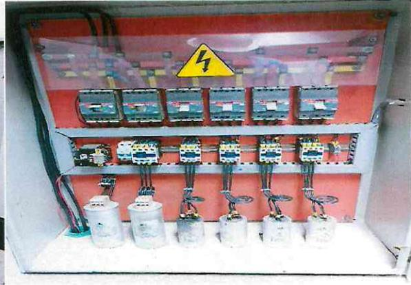
Terminación de optimización del tablero de control y potencia del sistema redundante para el normal funcionamiento alternado de las electrobombas de 30HP.
