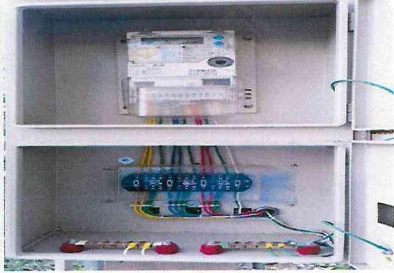
Terminación de optimización de tablero de banco de condensadores para dos electrobombas de 24HP.
