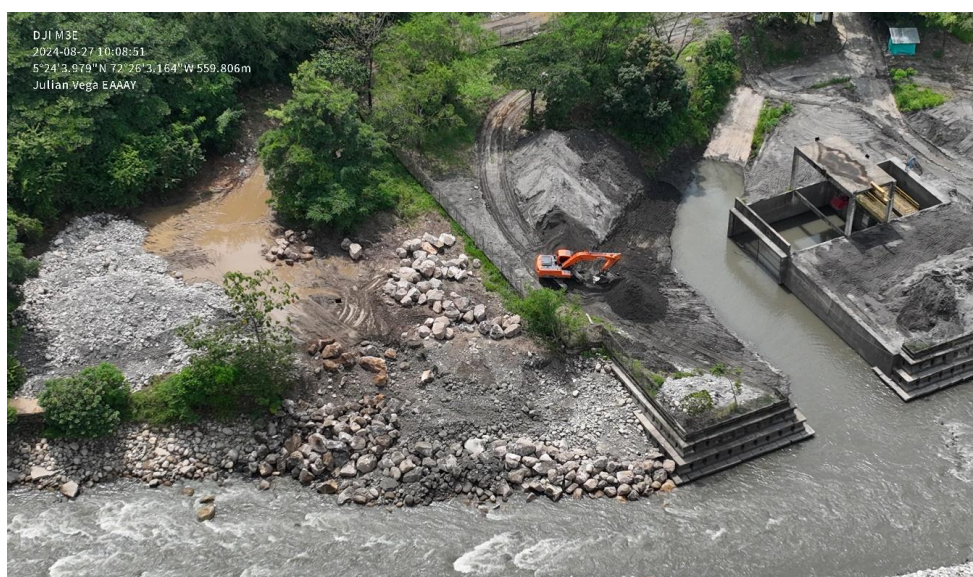
Foto 4 Estructura de Captación en el Rio Cravo Sur en amenaza sísmica alta.
