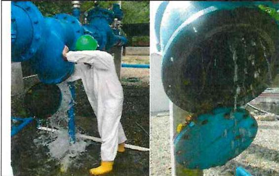
Debido a la cantidad de material orgánico (hojas, ramas) provenientes del punto de captación (La Tablona), ha sido necesario realizar continuas limpiezas al filtro en Yee de 8" y 12" instalados sobre la línea de aducción al sistema de tratamiento.
