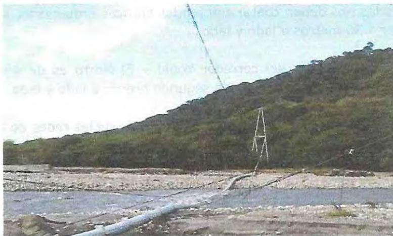
Foto 24 Colapso Paso Elevado año 2015, producto robo en elementos metálicos
