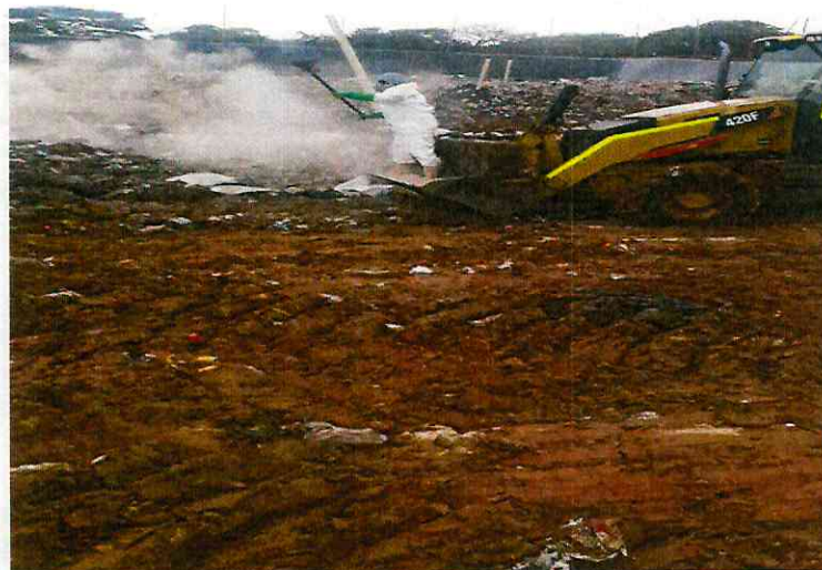
Aplicación de cal sobre los residuos en celda
