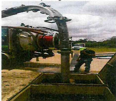
Mantenimiento y limpieza trampa de grasas
