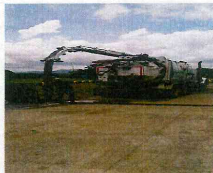
Mantenimiento y limpieza trampa de grasas PTAR
