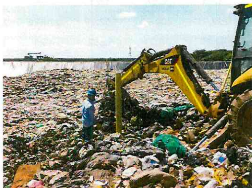
Mantenimiento de chimenea
