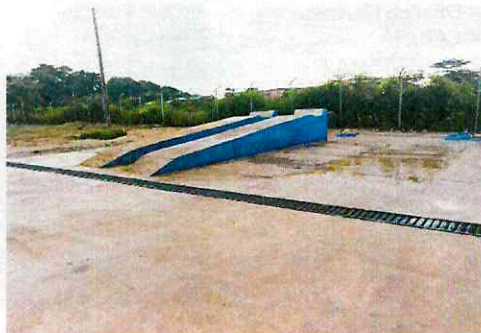
Lavado y limpieza del área de trabajo
