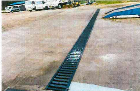
Limpieza de rejillas
