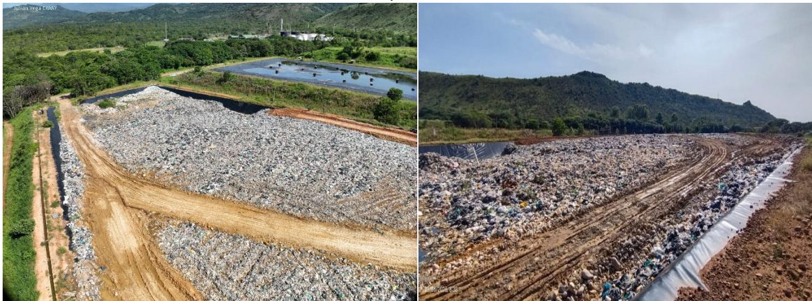
Foto 11 Estado de Operativo Trinchera 11
