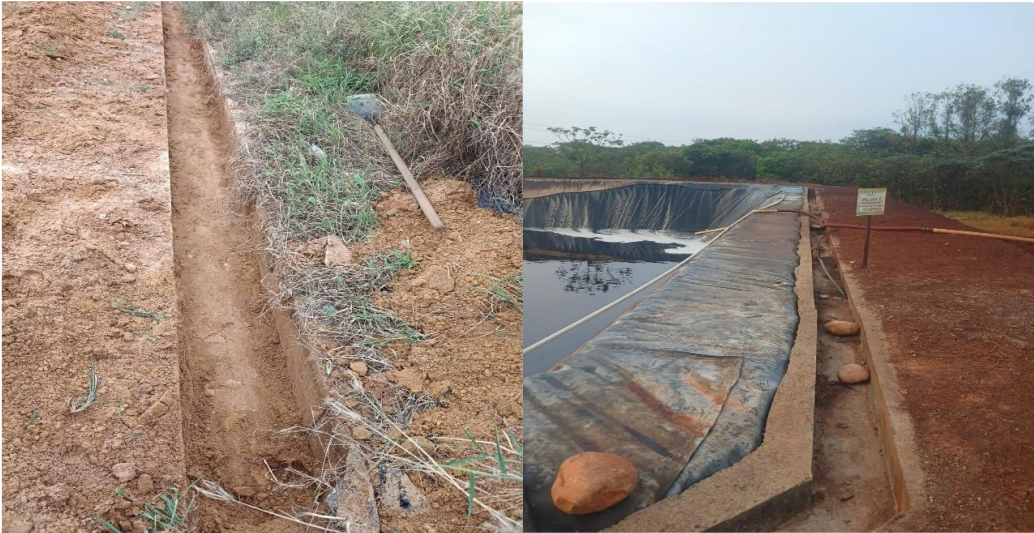
Foto 17 Limpieza de Cunetas
