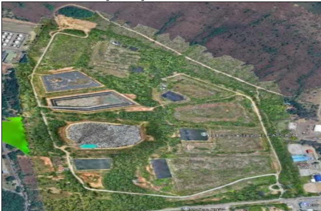
Imagen 2 Imagen Dron Relleno sanitario
