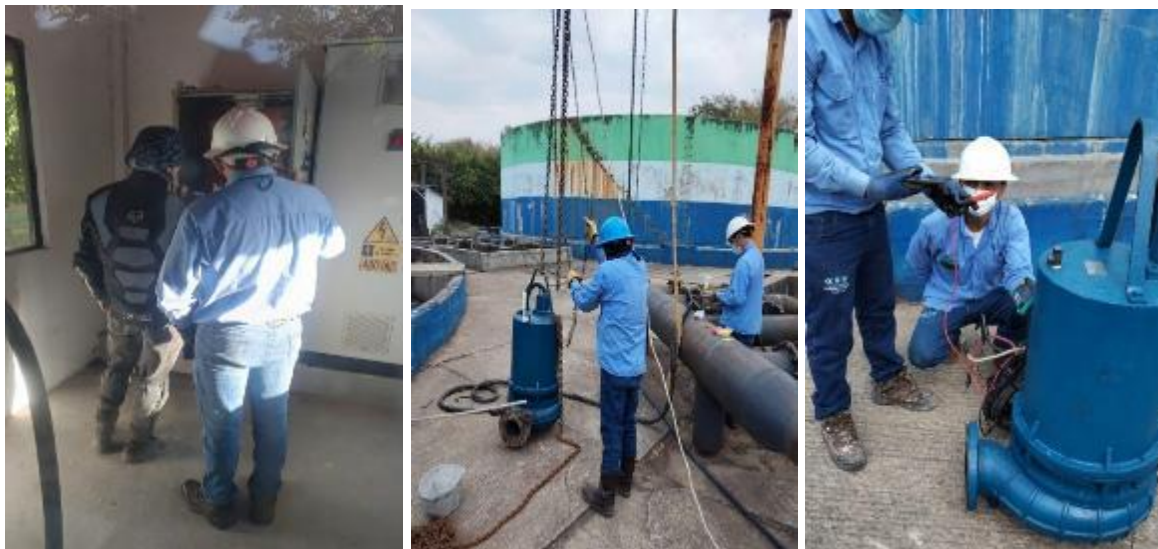
Revisión equipo electrógeno y falla de electrobombas
