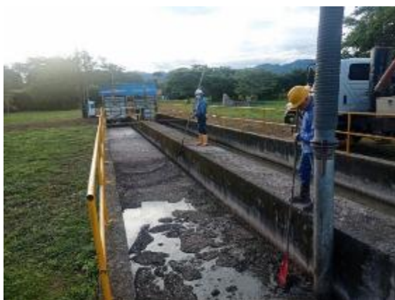
Actividad de extracción sobrenadantes en desarenadores con apoyo de succión.
