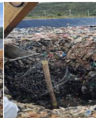
Recirculación de Lixiviados
