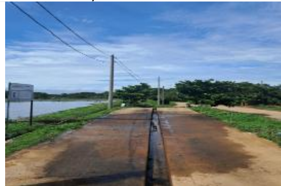
Limpieza de lava ruedas y sitio de descargue de lixiviados
