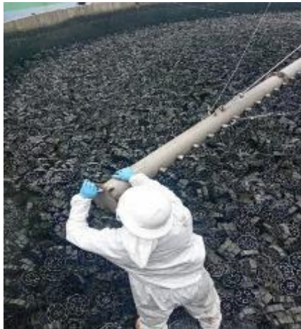
Mantenimiento de aspersores de los filtros percoladores
