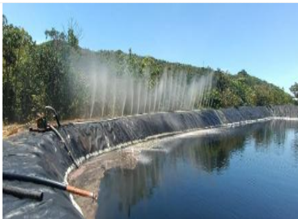
Sistema de aspersión de lixiviados
