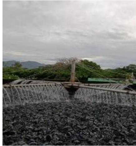
Mantenimiento de aspersores de los filtros percoladores
