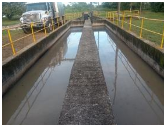
Actividad de extracción sobrenadantes en desarenadores con apoyo de succión.
