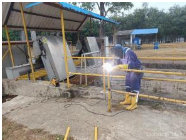
Reparación, pintura e instalación estructura metálica del pretratamiento
