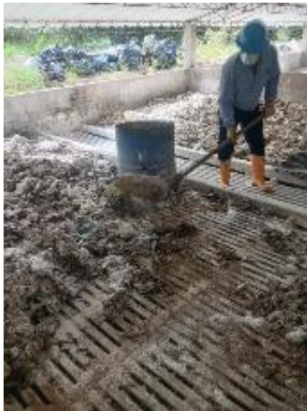
Deshidratación, volteo, retiro residuos sólidos y limpieza cámaras lechos de secado secos para disposición final
