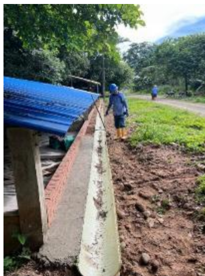
Construcción e instalación de canales perimetrales en lechos de secado
