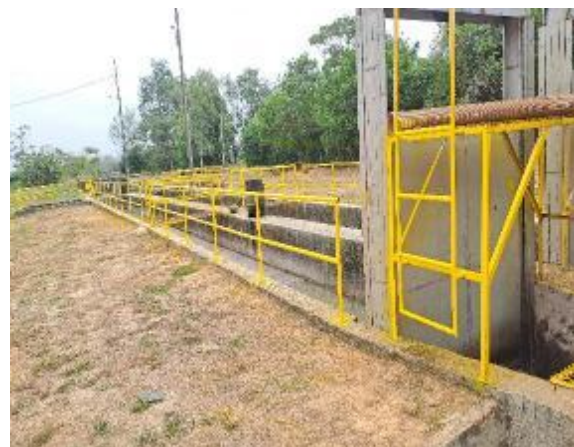
Reparación, pintura e instalación estructura metálica del pretratamiento
