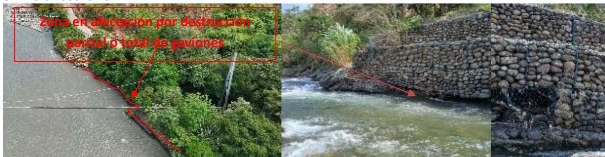
Foto 8 Destrucción parcial o total de gaviones margen izquierda paso elevado El Viejo
