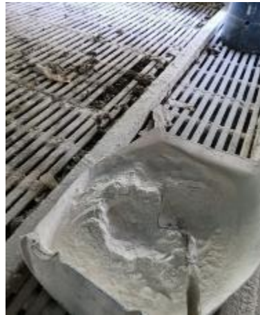
Deshidratación, volteo, retiro residuos sólidos y limpieza cámaras lechos de secado secos para disposición final
