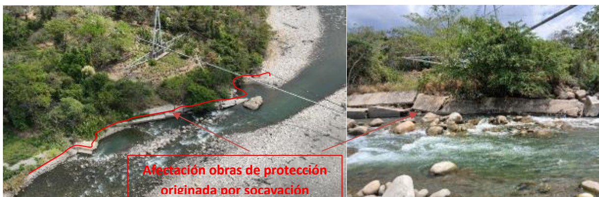
Foto Afectación obras de protección por fenómeno de socavación lateral costado izquierdo paso elevado El Grande
